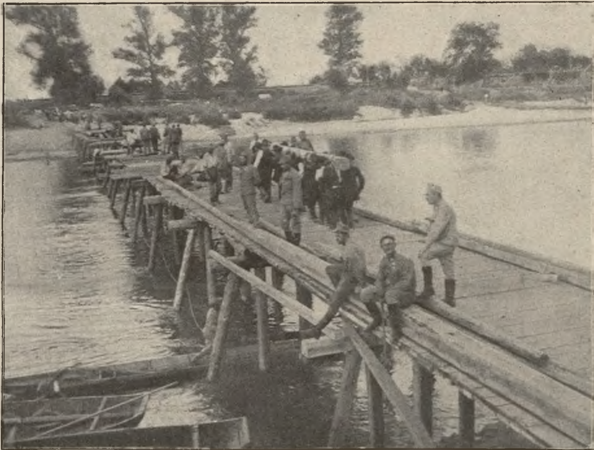
Z oswobodzonej Galicji: Most na Sanie koło Pniowa, zbudowany przez austriackich pionierów. Na brzegu widać rosyjskie rowy strzeleckie.
