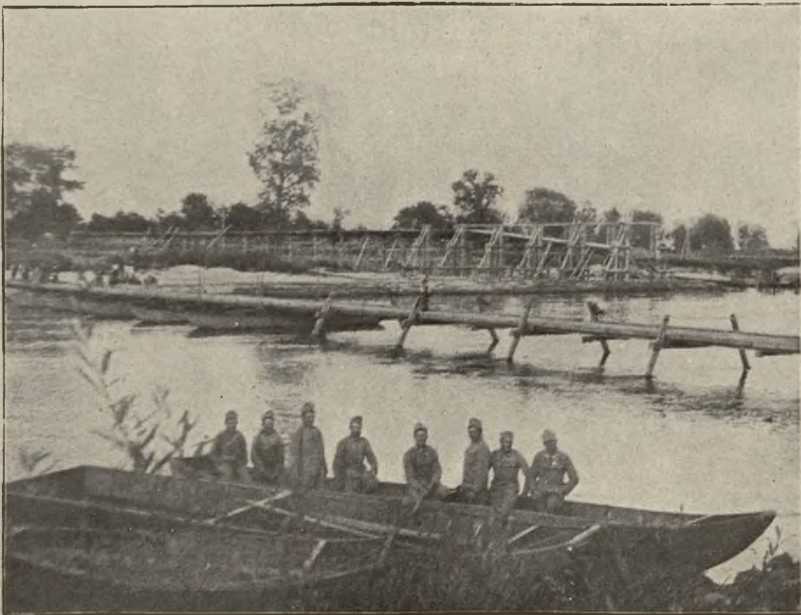
Z oswobodzonej Galicji: Most pontonowy na Sanie koło Pniowa. W głębi widać most, który budowali Rosyanie.
