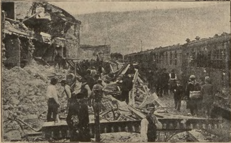
Pociąg na zburzonej stacji
