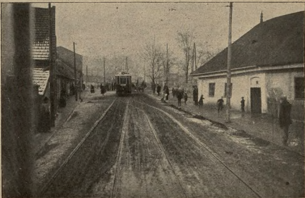
Nowa linia tramwajowa w Krakowie: Przybycie pierwszego wozu, z członkami prezydentów m Krakowa i Podgórza, na ostatni przystanek nowej linii pod Salwatorzem.
