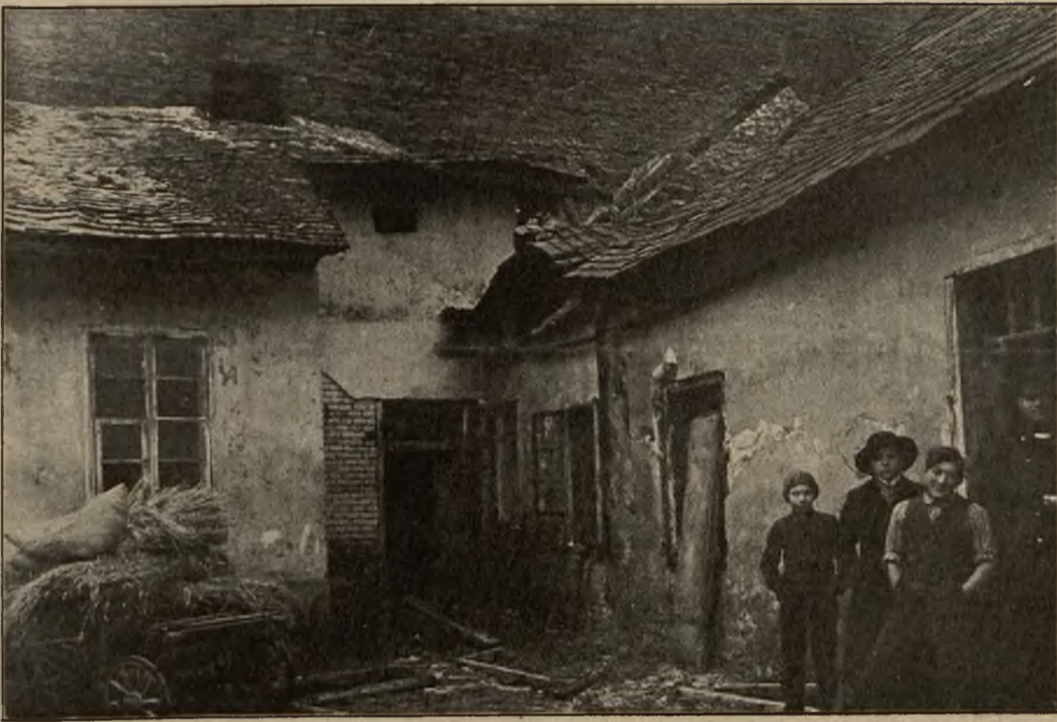
Katastrofa budowlana: Zawalony dach w domu przy ul. Żółkiewskiej we Lwowie.
