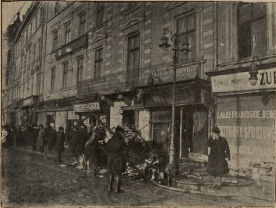
Znowu wybuch benzyny: Zgliszcza wyrzucone ze spalonego sklepu przy ulicy Hetmańskiej we Lwowie. (Fot. Biuro zdjęć fot., Lwów).
