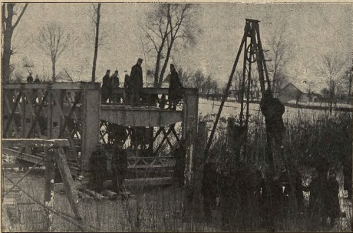
Nowy most pod Przemysłem: Budowa nowego mostu kolejowego na rzece Wiarze przez wojsko. (Fot. M. Todt, Przemysł).
