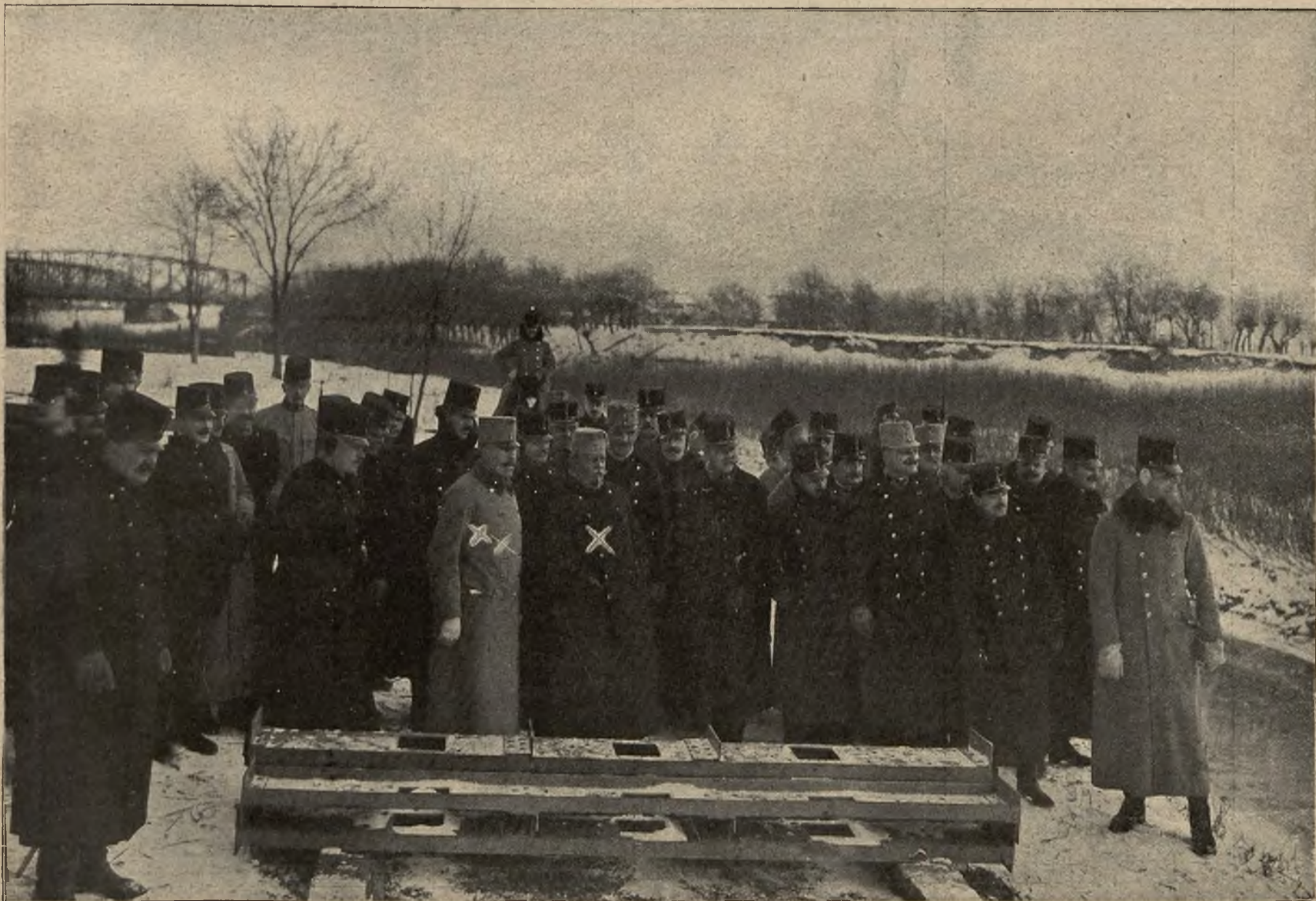
Nowy most pod Przemysłem: Władze wojskowe przy nowym moście kolejowym na rzece Wiarze. (X) Komendant korpusu przemyskiego jen. Kummer. (XX) Kierownik budowy.
