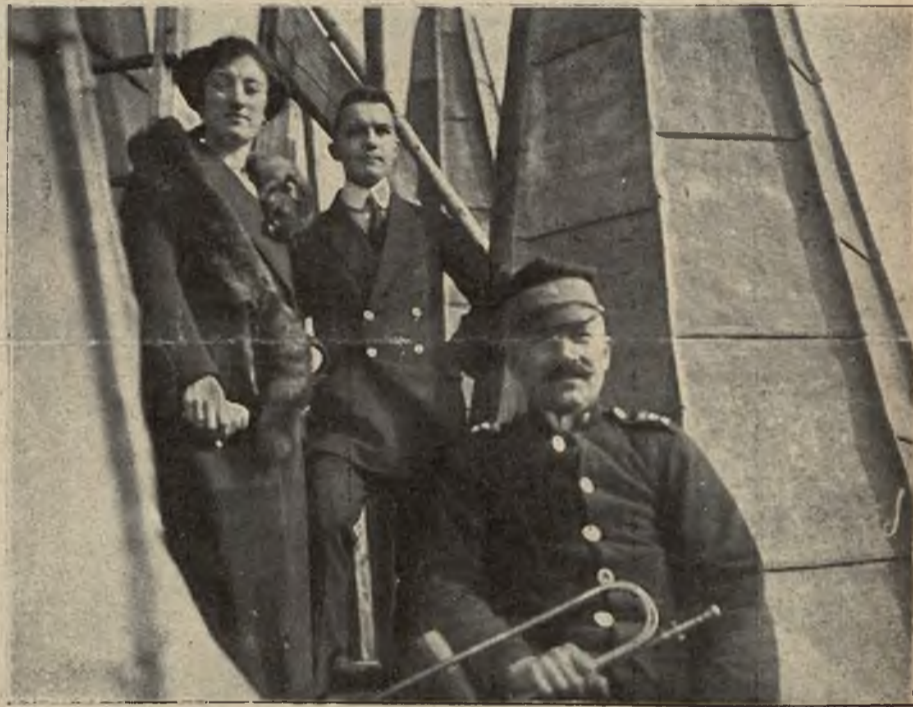
Odnowienie wieży Maryackiej w Krakowie: Pod koroną wieży, na wysokości 65 m.
