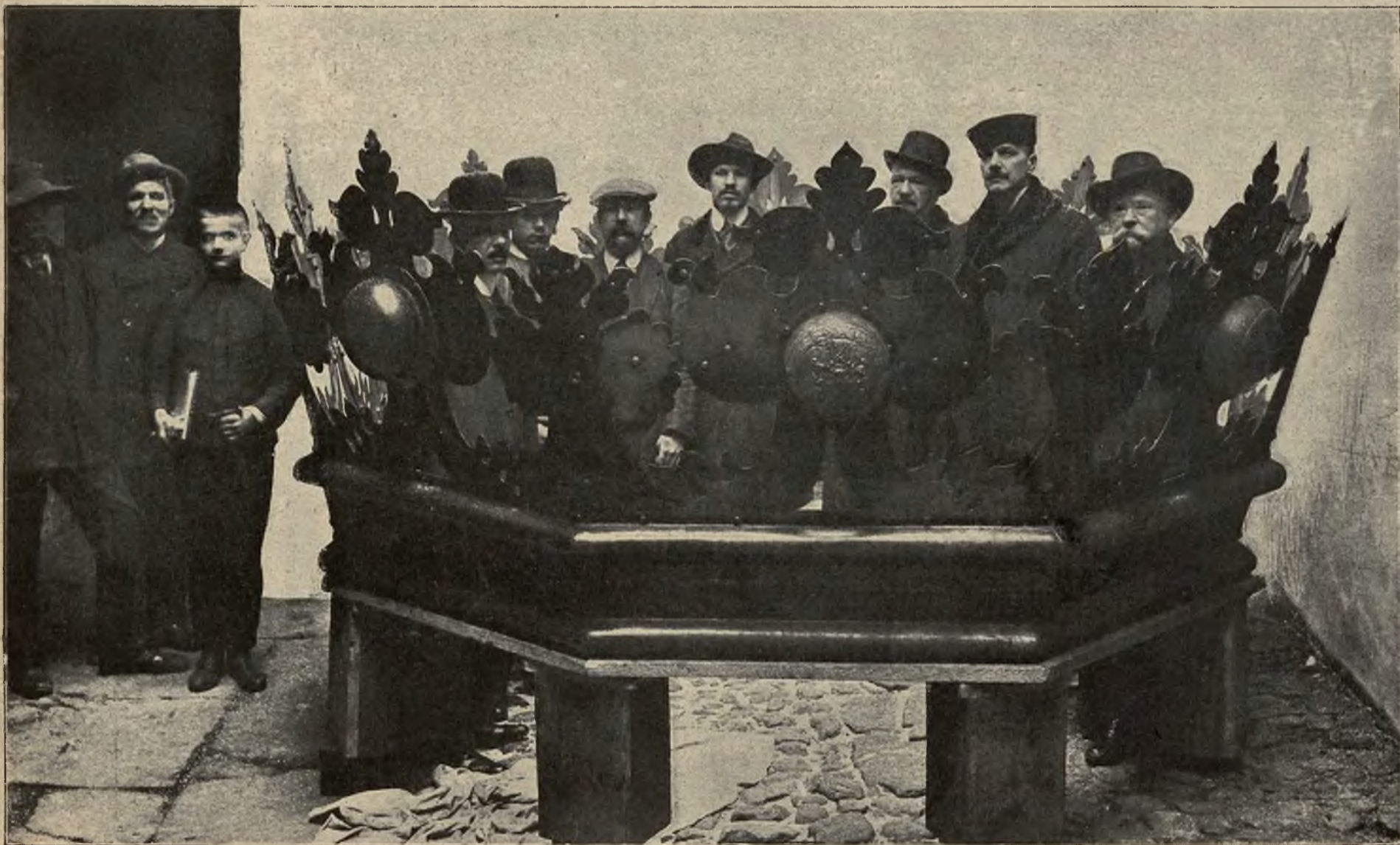
Odnowienie wieży Maryackiej w Krakowie: Korona szczytowa wieży, odnowiona w zakładzie p. H. Sztorca.
