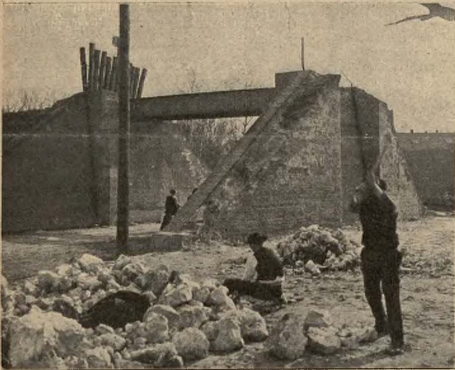
Ginący „mały“ Kraków: Rozebrany most kolejowy u wylotu ulicy Łobzowskiej.
