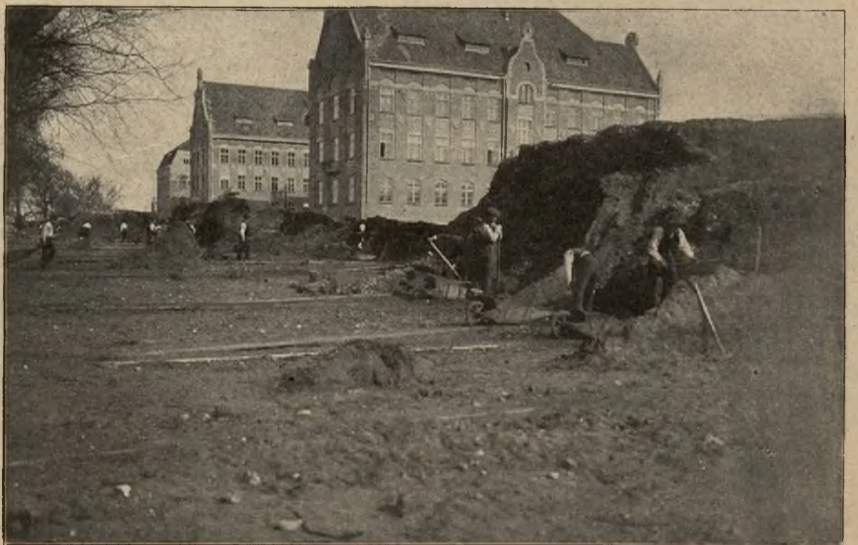
Ginący „mały“ Kraków: Rozkopywanie wału pod parkiem dra Jordana.
