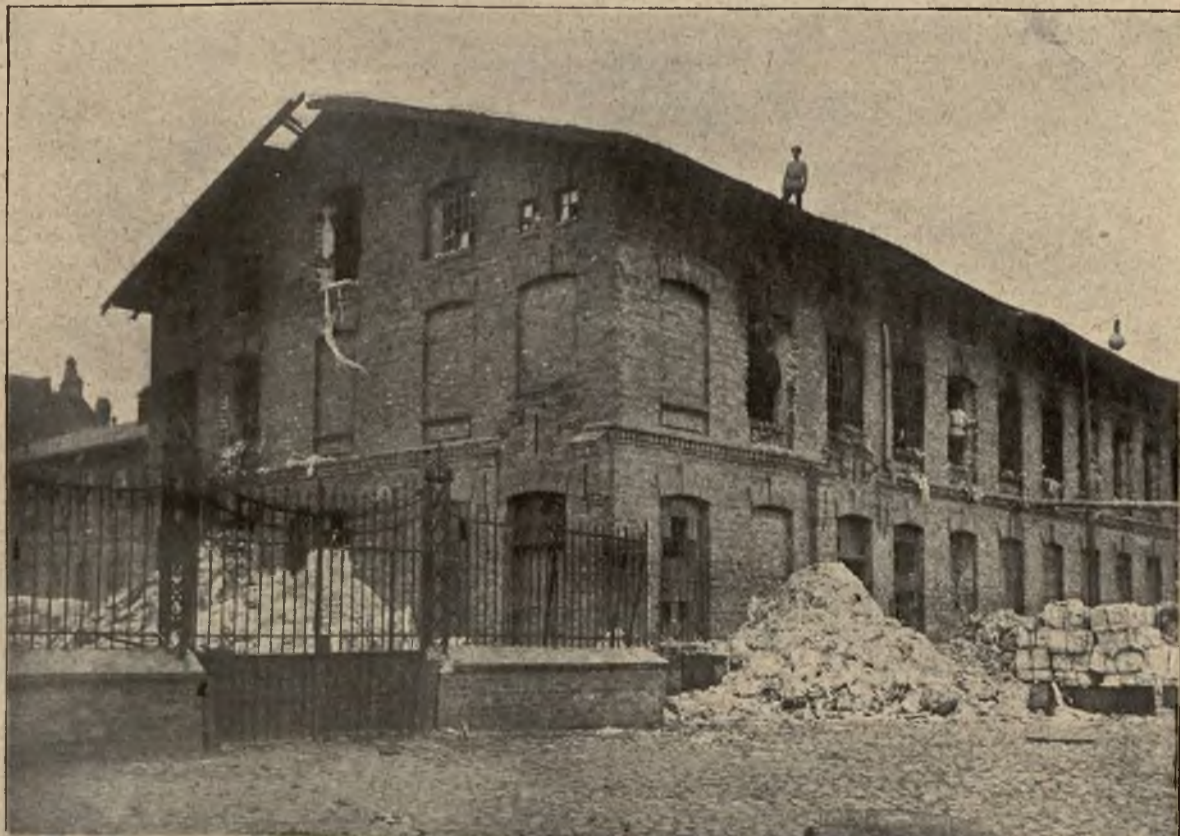
Pożar więzienia: Papiernia mokotowskiego więzienia dla „katorżników“ w Warszawie po pożarze.
