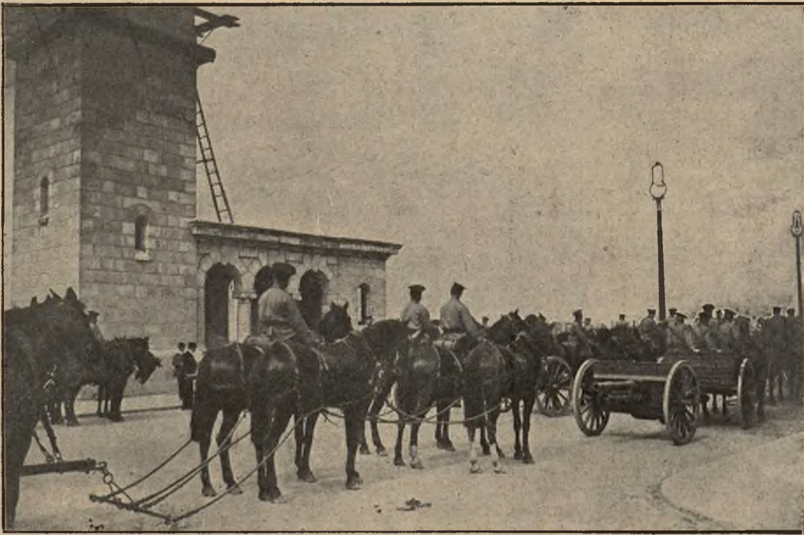
Nowa arteria komunikacyjna w Warszawie: Ostateczna próba wytrzymałości trzeciego mostu. (Fot. Maryan Fuks, Warszawa).
