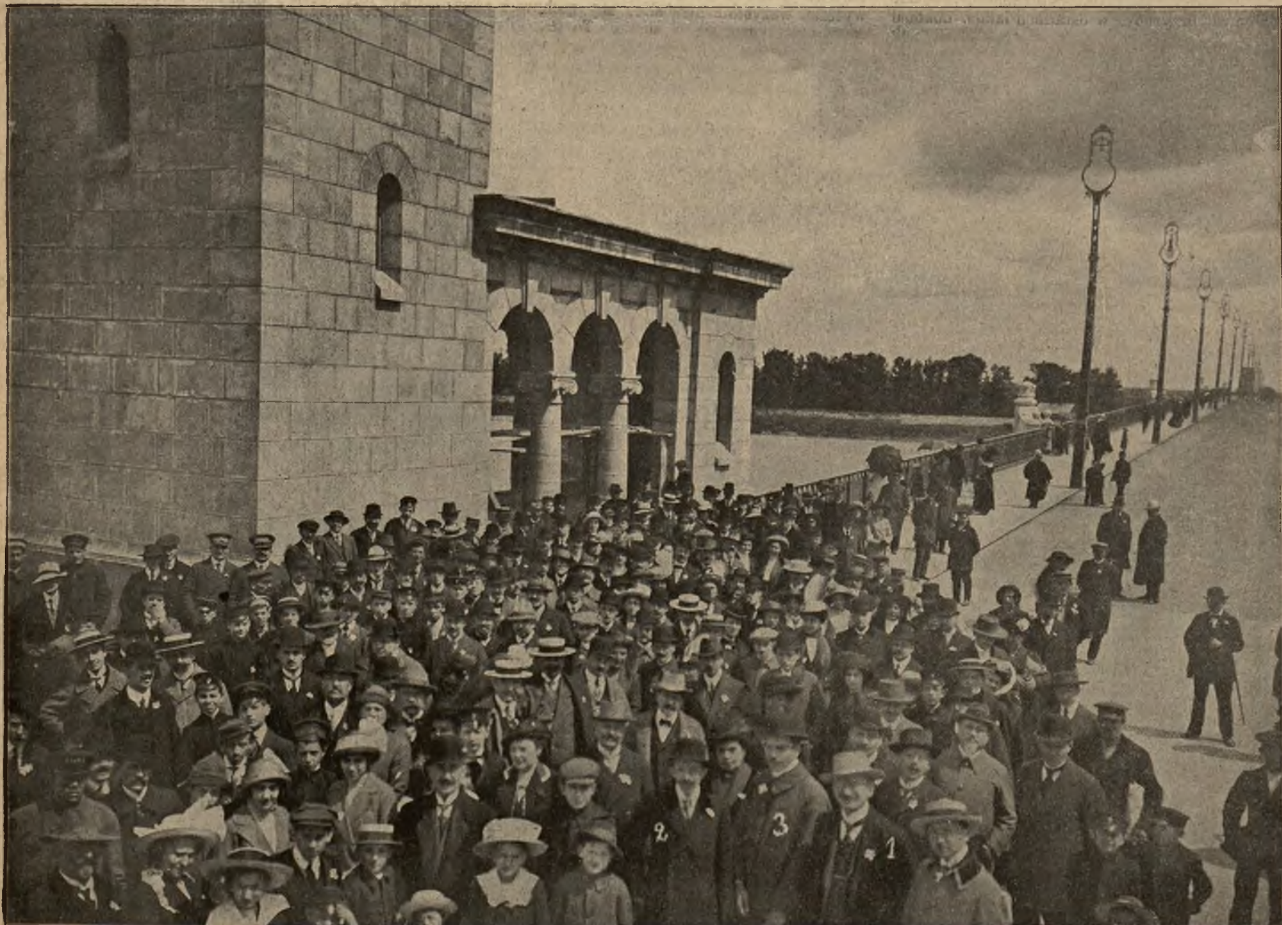
Po otwarciu trzeciego mostu w Warszawie: Wycieczka Stow. kupców polskich na trzecim moście. 1) Gospodarz Stow. p. Hirszel, 2) inż. B. Plebiński i 3) inż. W. Paszkowski, kierownicy budowy mostu. (Fot. Maryan Fuks, Warszawa).
