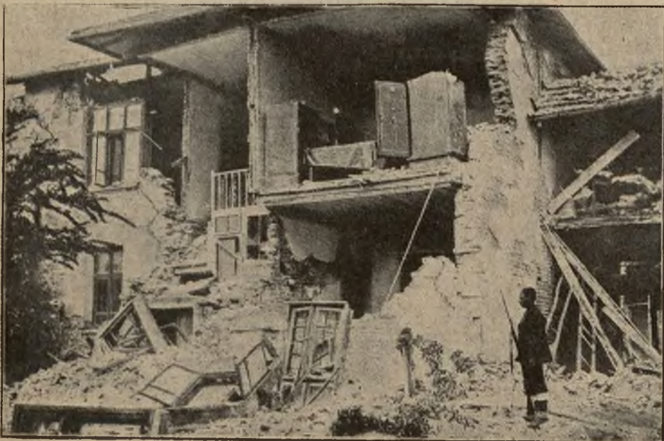
Budynek banku w Tirnowie po katastrofie.
