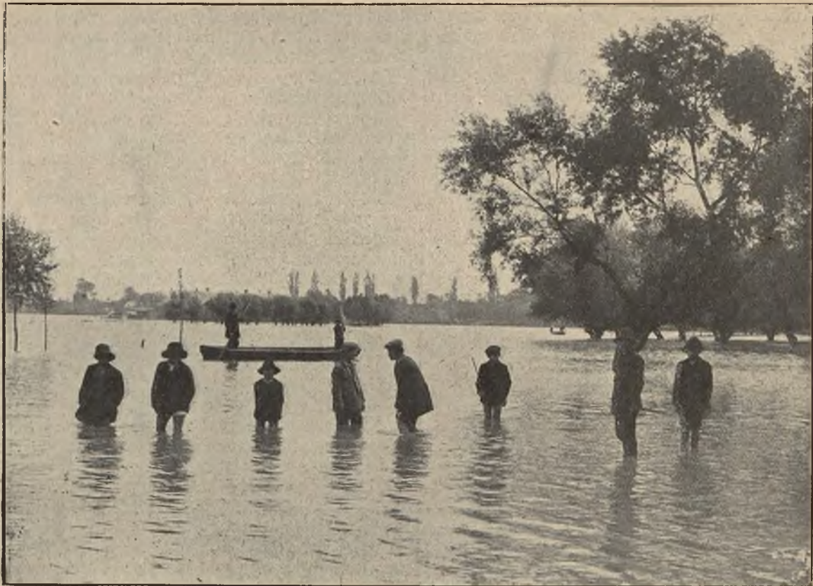
Wielka klęska powodzi: Przedmieście „Wilcza“ w Przemyślu, zalane przez wody Sann.
