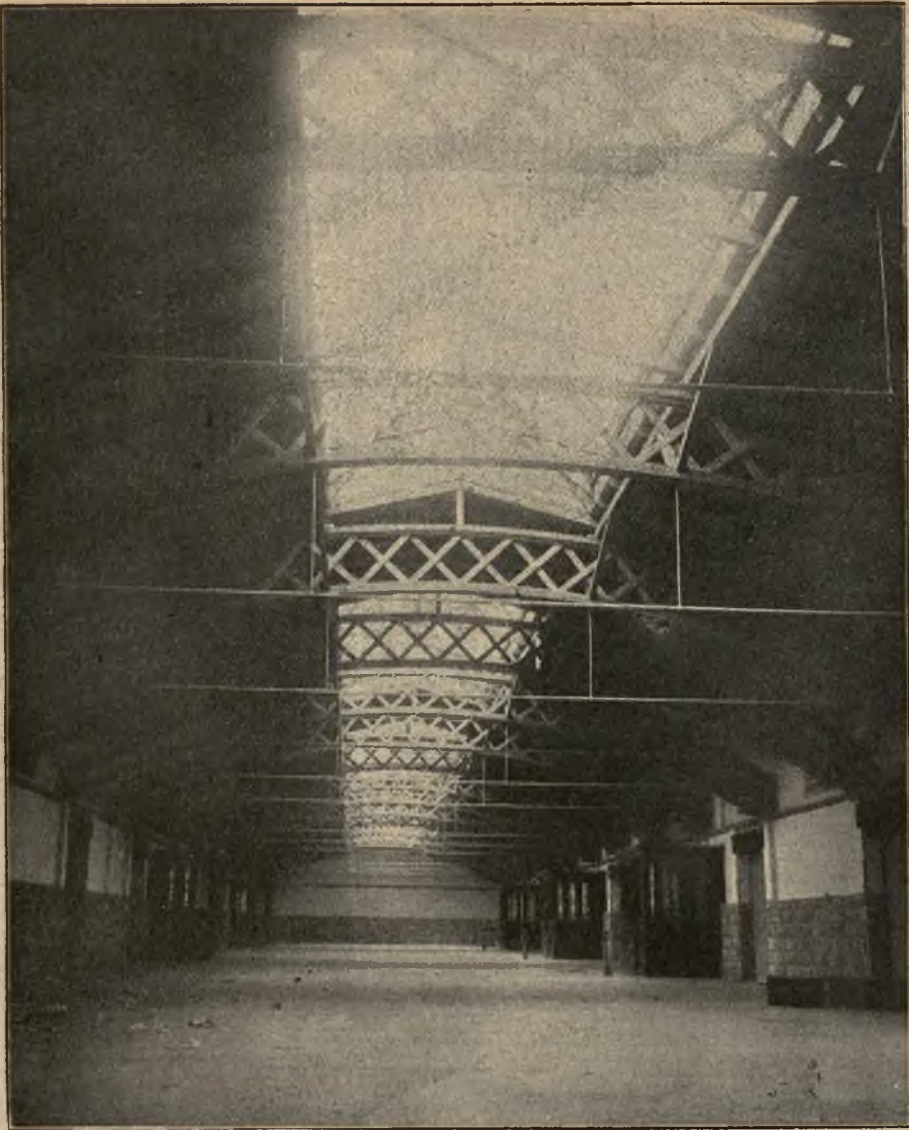
Nowy dworzec towarowy w Krakowie: Wnętrze największego magazynu towarowego.
