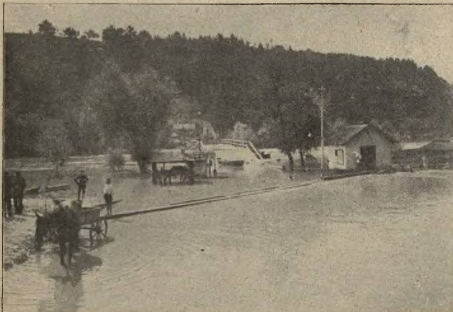
Gorąca powódź w Piszczanach: Most pontonowy na rzece Waadze, odcięty wodą od świata.
