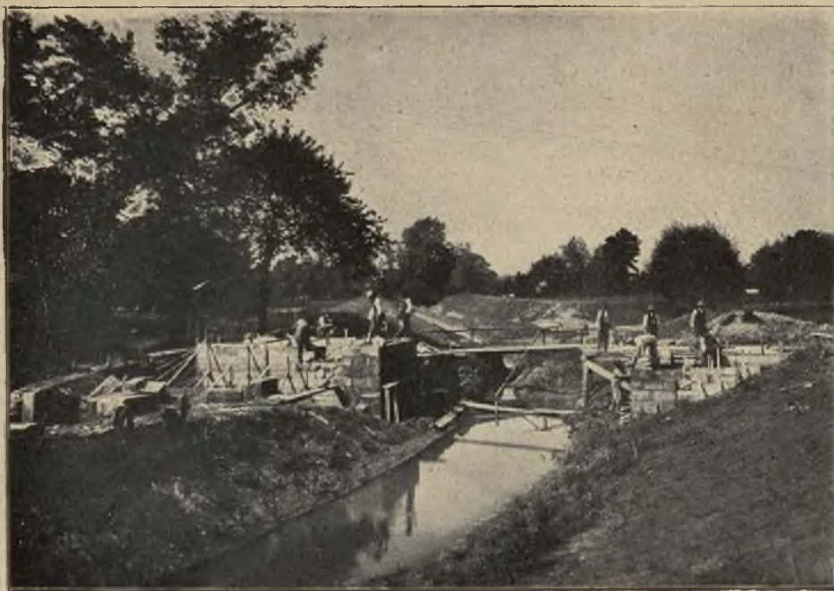
Przyczółki mostu żelazno-betonowego na korycie potoku Brzeźnica.
