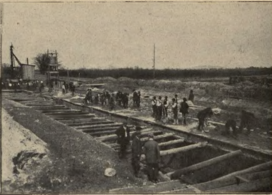
Budowa lewaru pod kanałem w Kossowie.
