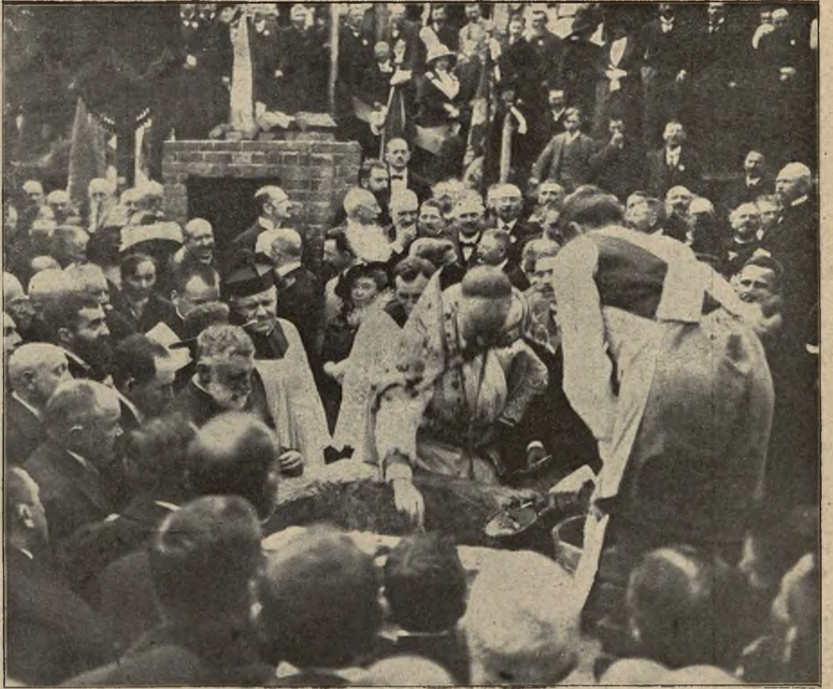
Nowa placówka rękodzielnicza we Lwowie: Ks. arcybiskup Bilczewski rzuca pierwszą kielnię przy budowie domu Izby rękodzielniczej. (Fot. M. Waydowicz, Lwów).
