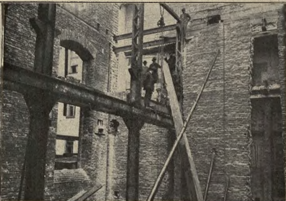
Nowy budynek podstacyi przy ul. Łobzowskiej.
