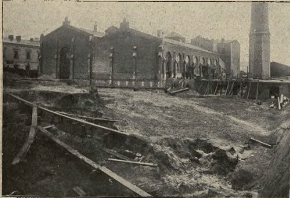
Miejsce, gdzie stanie nowa centrala elektryczna.
