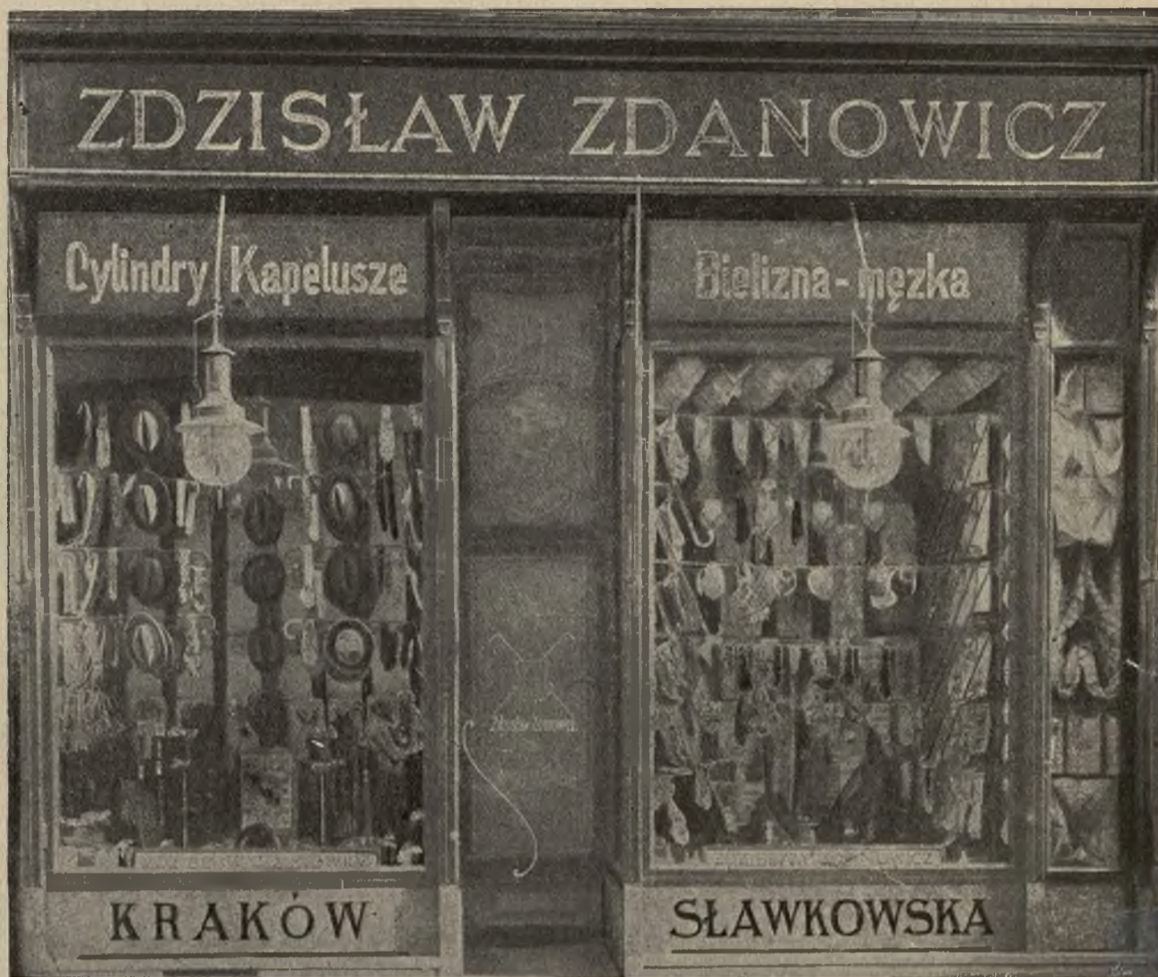
Zewnętrzny widok sklepu przy ul. Sławkowskiej.
