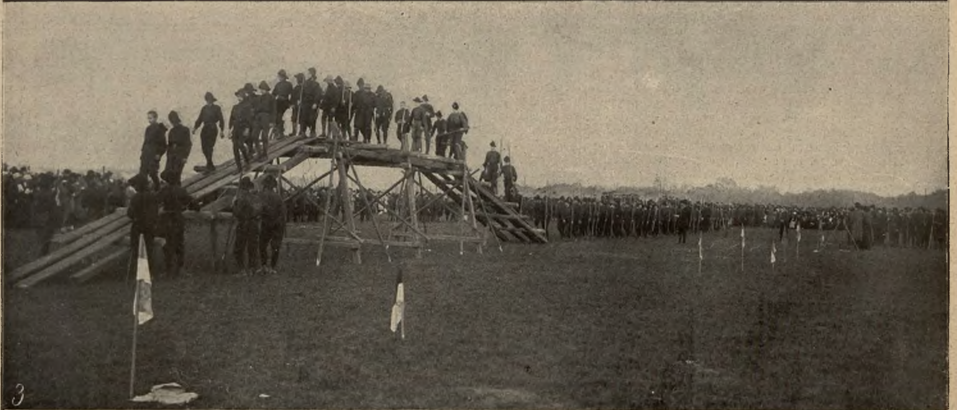
Ku czci ks. Józefa: Ćwiczenia zlotowe Sokołów na polu wyścigowym w Krakowie. 1. Budowa mostu przez skautów. W głębi obóz skautów. 2. Ćwiczenia sokolic. 3. Przemarsz skautów przez most.
