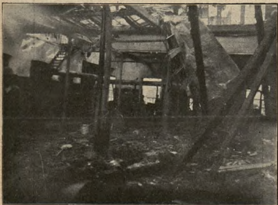
Zniszczona przez pożar hala maszyn fabryki konserw w Mszanie Dolnej.
