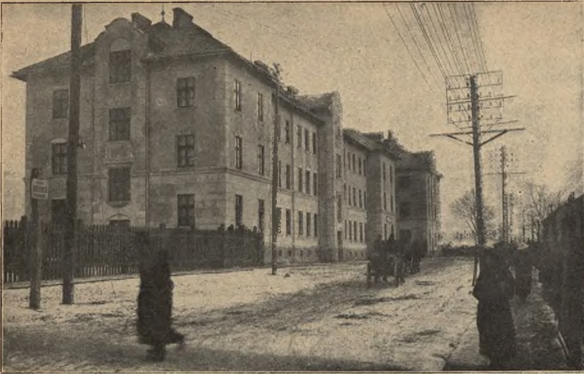
Poświęcenie domów kolejowych w Tarnopolu: Front domu dla służby. Na końcu jeden z domów dla podurzędników.
