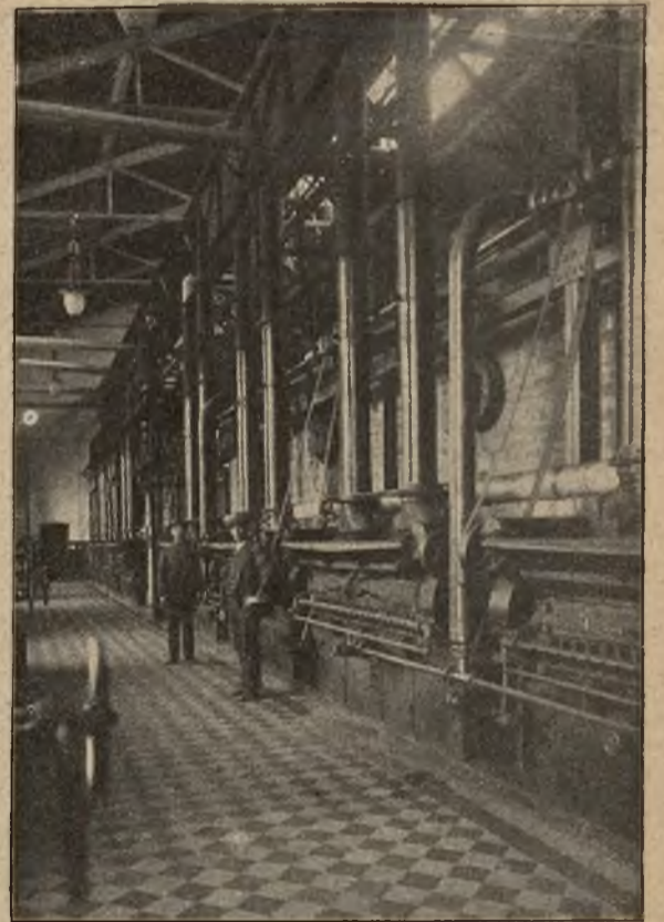
Nowa warzelnia soli w Wieliczce: Kotłownia.
