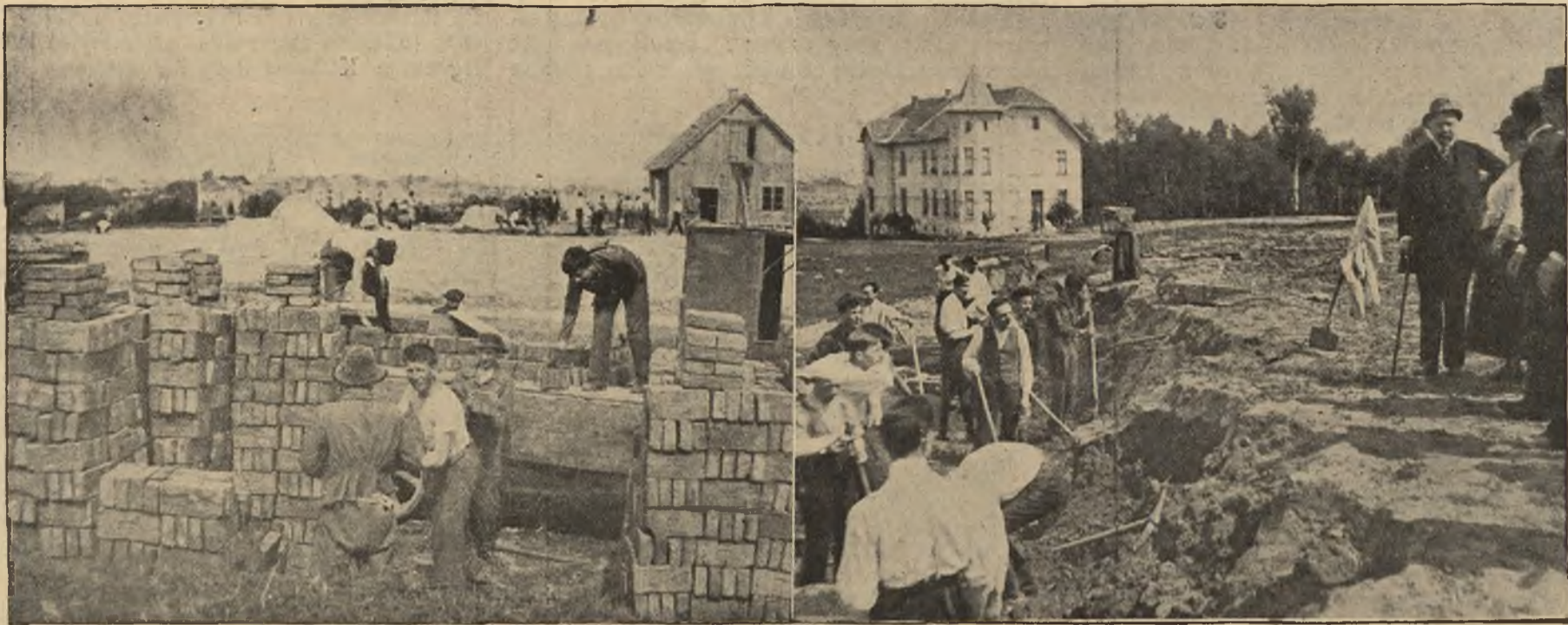
Budowa II. Doma Techników we Lwowie: I. Zwózka cegły na plac budowy. II. Wiceprezydent m. Krakowa Rolle, z delegacją Zjazdu Miast na placu budowy.
