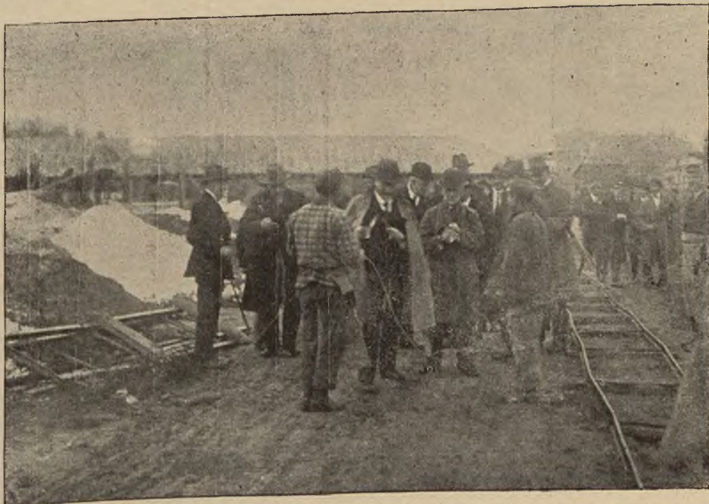
Budowa domu Akademickiego w Warszawie: Po zwiedzeniu budowy domu. Goście przy wyjściu otoczeni zostali przez robotników sznurem i musieli się wykupić. Na pierwszym planie minister Głabiński zaglądający do swego pugilaresu.
