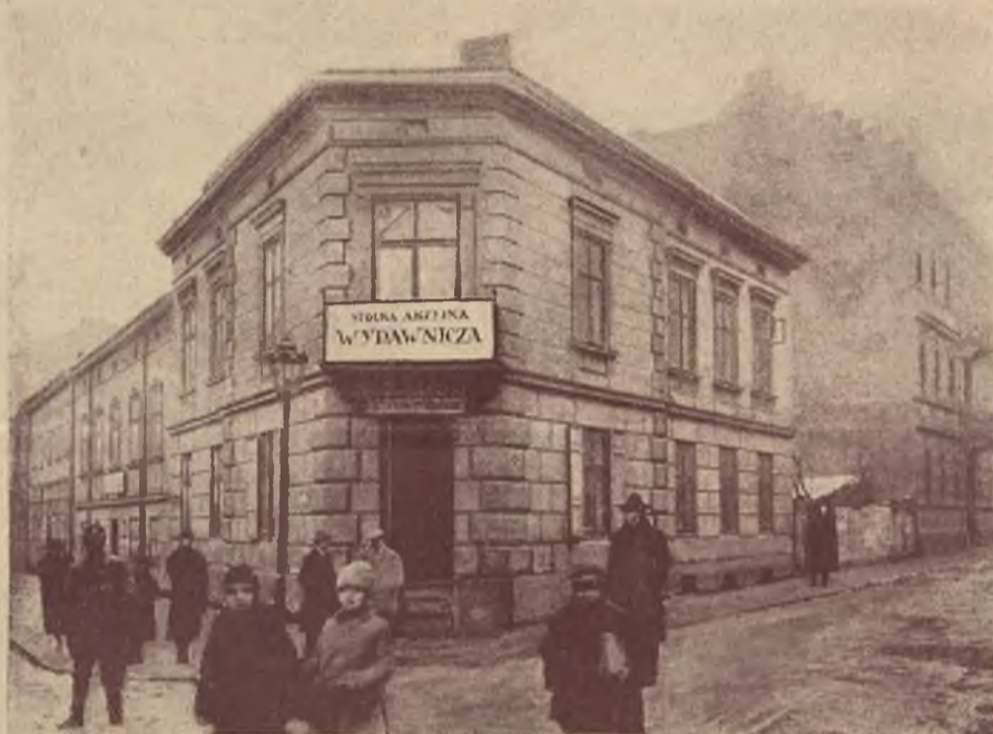
Dwie realności „Spółki Akcyjnej Wydawniczej“ we Lwowie, przy ul. Chorążczyzny i Ossolińskich, obecnie burzone, w miejsce których buduje się trzechpiętrowy gmach monumentalny.
