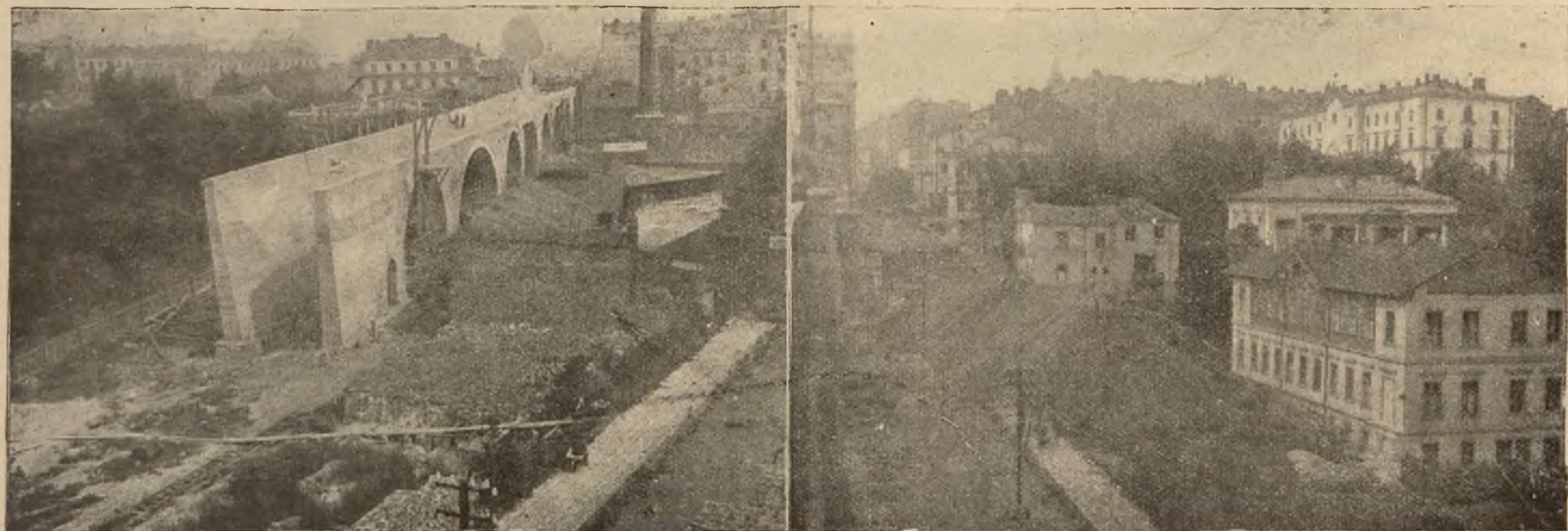
Budowa czwartego mostu na Wiśle i tunelu w Warszawie; Budujący się wiadukt kolejowy w Al. 3-go Maja obok mostu Poniatowskiego. Roboty około nasypu pod tor kolejowy mający połączyć wiadukt z tunelem.
