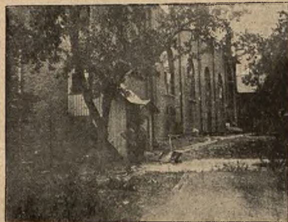
Zniszczona placówka polska na Pomorzu: Zgliszcza spalonego teatru w Grudziądzu
