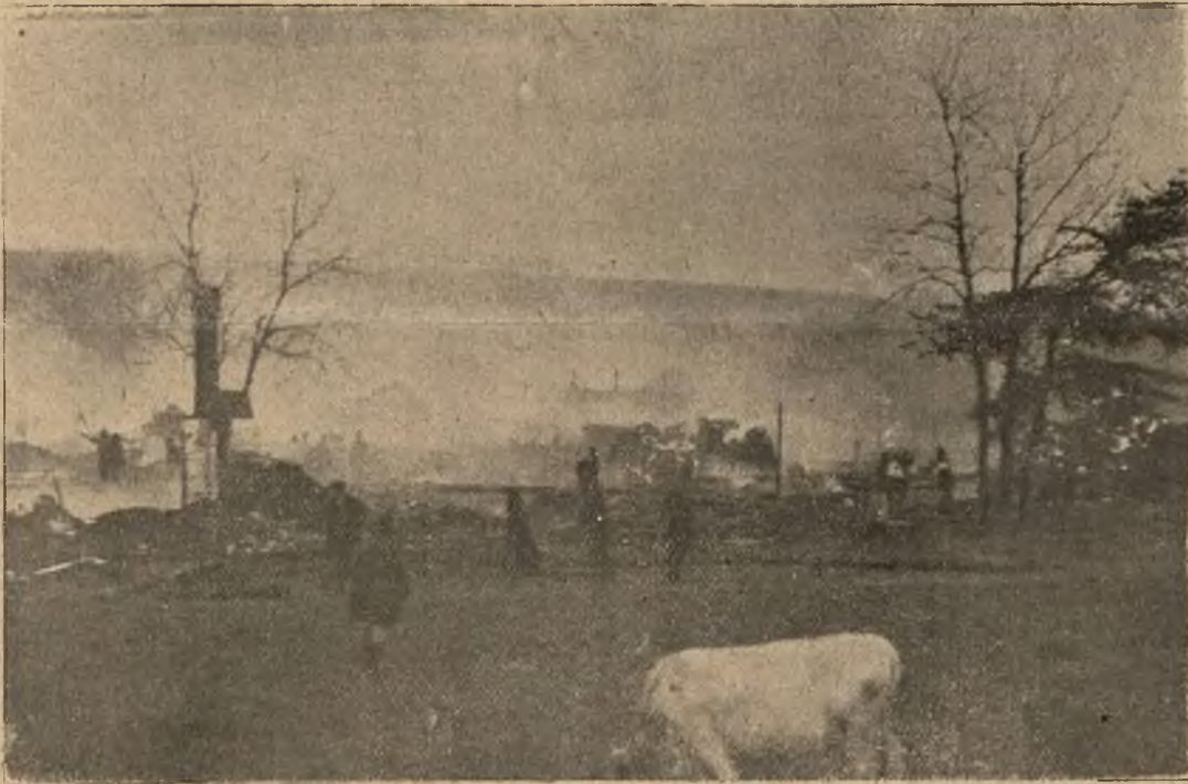
Wielki pożar w Jamnicy: Widok spalonych domów widziany od strony południowej (strony dworca kol.).
