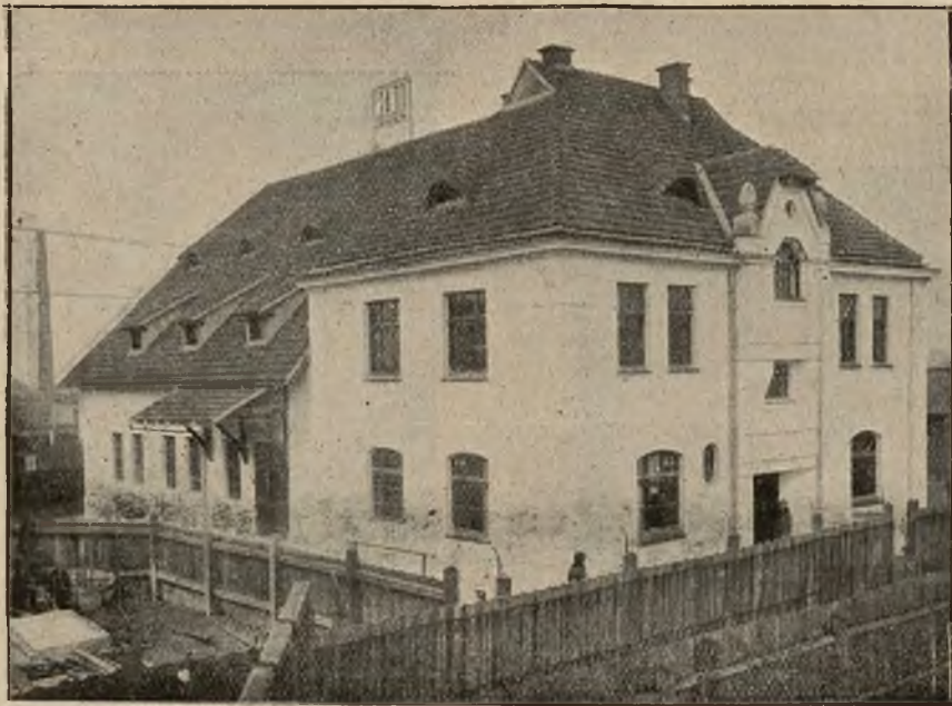
Budynek ze składami Zw. Spółdz. jajcz. przy ul. Łokietka w Krakowie.
