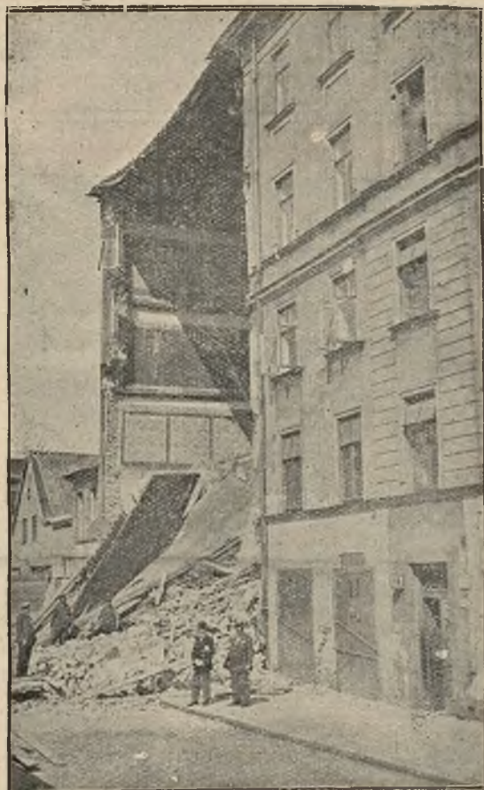
Zawalony dom czteropiętrowy w Warszawie.
