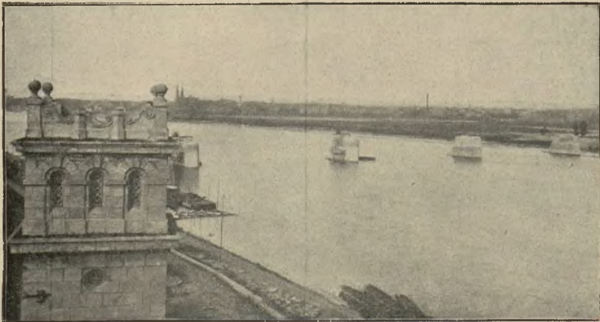
Budowa nowego mostu kolejowego w Warszawie. Filary mostu są już na ukończeniu. W najbliższym czasie rozpocznie się budowa przęsła. Fot. J. Morzycki.
