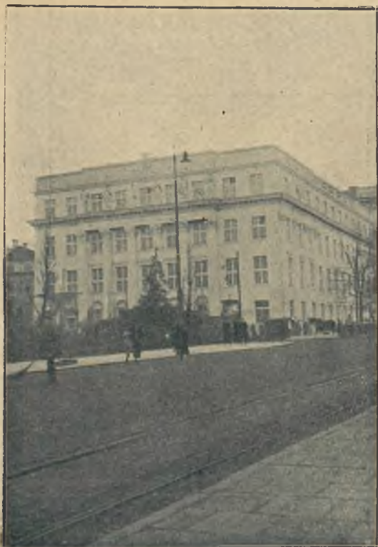
Nowy gmach w Alejach Ujazdowskich w Warszawie przeznaczony na gimnazjum żeńskie im. Król. Jadwigi, w tych dniach zostanie oddany do użytku.
