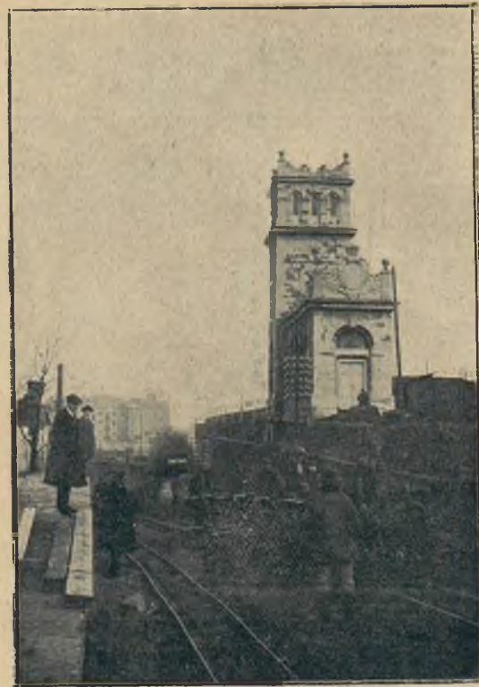
Budowa tunelu pod Aleją 3-go Maja. Wyjście z tunelu na nowy wjadukt kolejowy; na zdjęciu widać kolejkę linową, dowożącą materiał budowlany.
