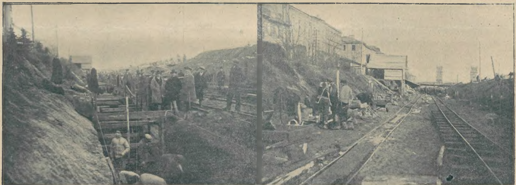
Przebudowa węzła kolejowego w Warszawie. Jak wiadomo, kolejowy węzeł warszawski ma ulec gruntownej przebudowie. W związku z nią buduje się nową linię kolejową, która ma biec od głównego dworca tunelem pod Alejami Jerozolimskimi i aleją Trzeciego Maja, potem mostem przez Wisłę. Prace nad budową mostu i tunelu są w toku. Zdjęcia przedstawiają budowę tunelu. 1) Zastępca naczelnika przebudowy węzła p. inż. Fihel i kierownik robót p. inż. Domański nad głębokim wykopem pod betonowe ściany tunełu. 2) Po ukończeniu obmurowań górnych i bocznych tunełu w najbliższym czasie wykop wzdłuż ulicy zostanie zasypyany ziemią, ruch uliczny przywrócony, a dalsze roboty przeniesione pod ziemię. Rozkopana ulica 3-go Maja. F. J. Rutk.
