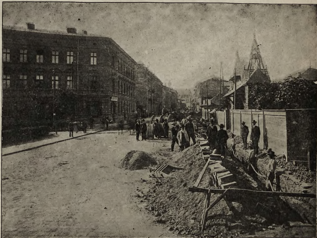
Elektrownia miejska w Krakowie: Zakładanie przewodów elektrycznych w ulicy Starowiśniej.
