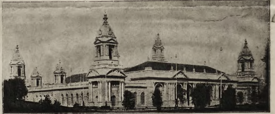
Z wystawy metalowej w Saint Louis: Pawilon budowy maszyn.
