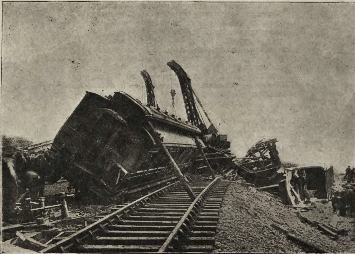
Katastrofa kolejowa: Tor kolejowy przed uprzątnięciem.
