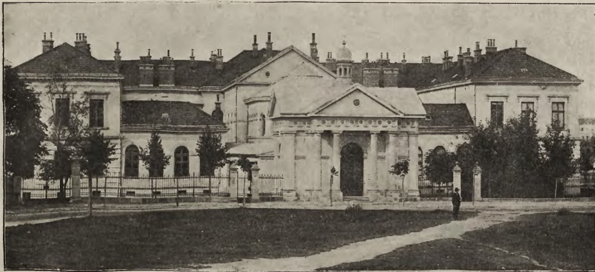
W obronie nauki: Zabudowania kliniczne na Łyczakowie.
