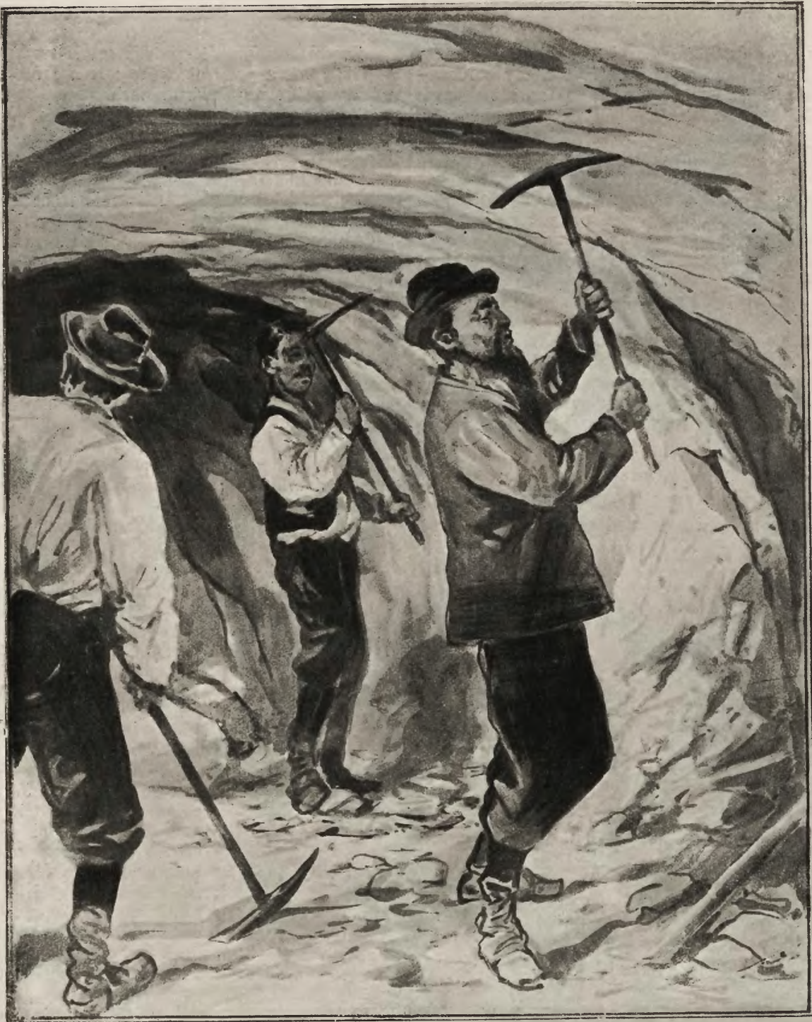
Przebiecie tunelu Symplonskiego: Robotnicy zajęci rozszerzaniem otworu w tunelu.
