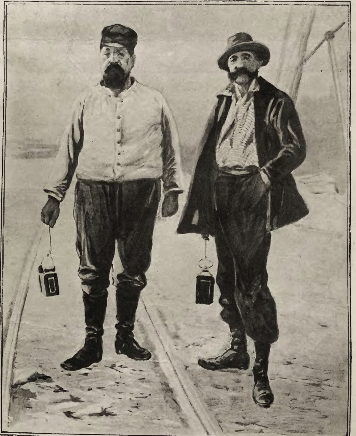
Przebiecie tunelu Symplonskiego: Inżynierzy M. Herrmann Hansler i M. Hugo v. Kager przy oglądaniu wykończonej świeżo trasy w tunelu.
