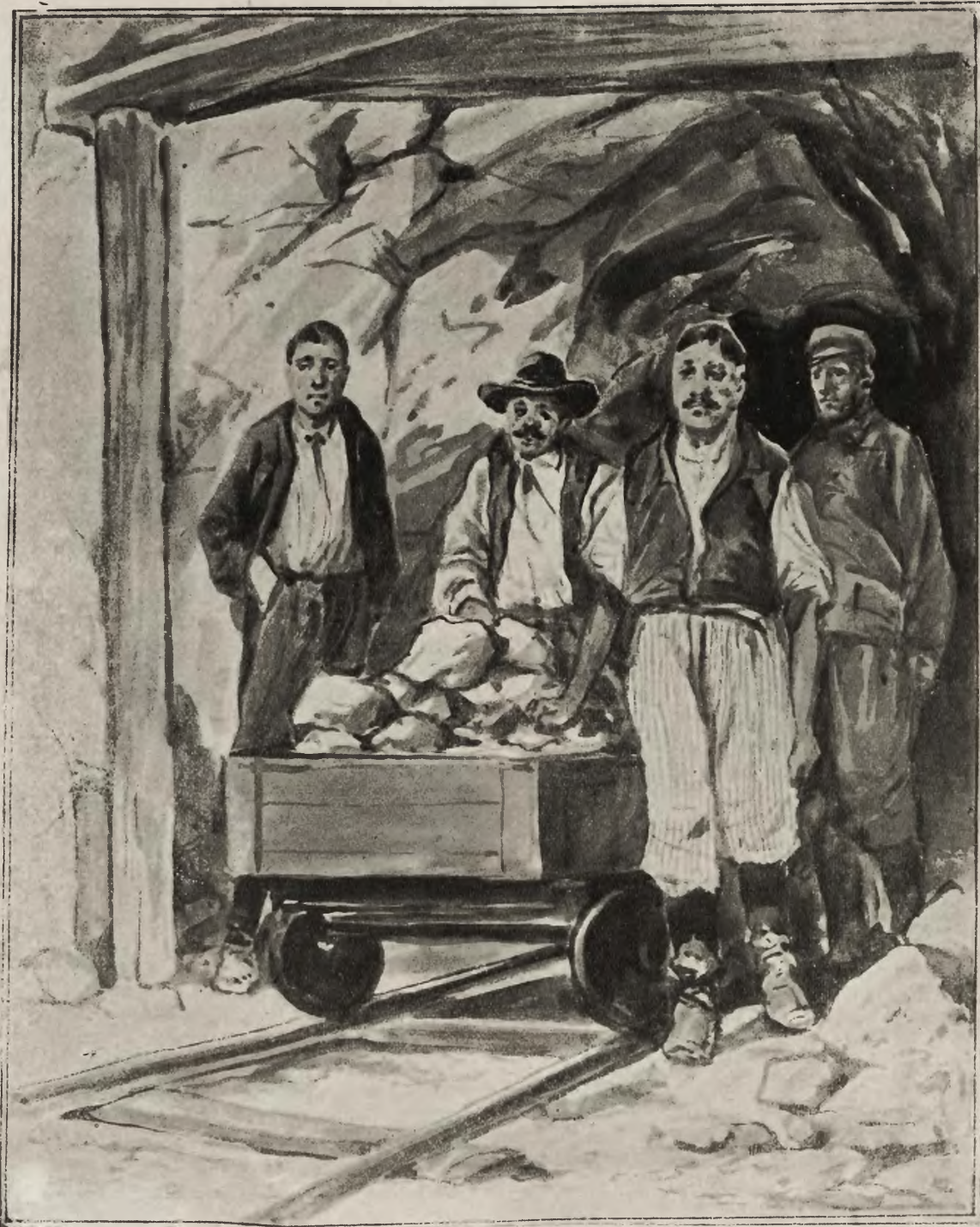
Przebiecie tunelu Symploniańskiego: Robotnicy zajęci wywożeniem gruzów z tunelu.
