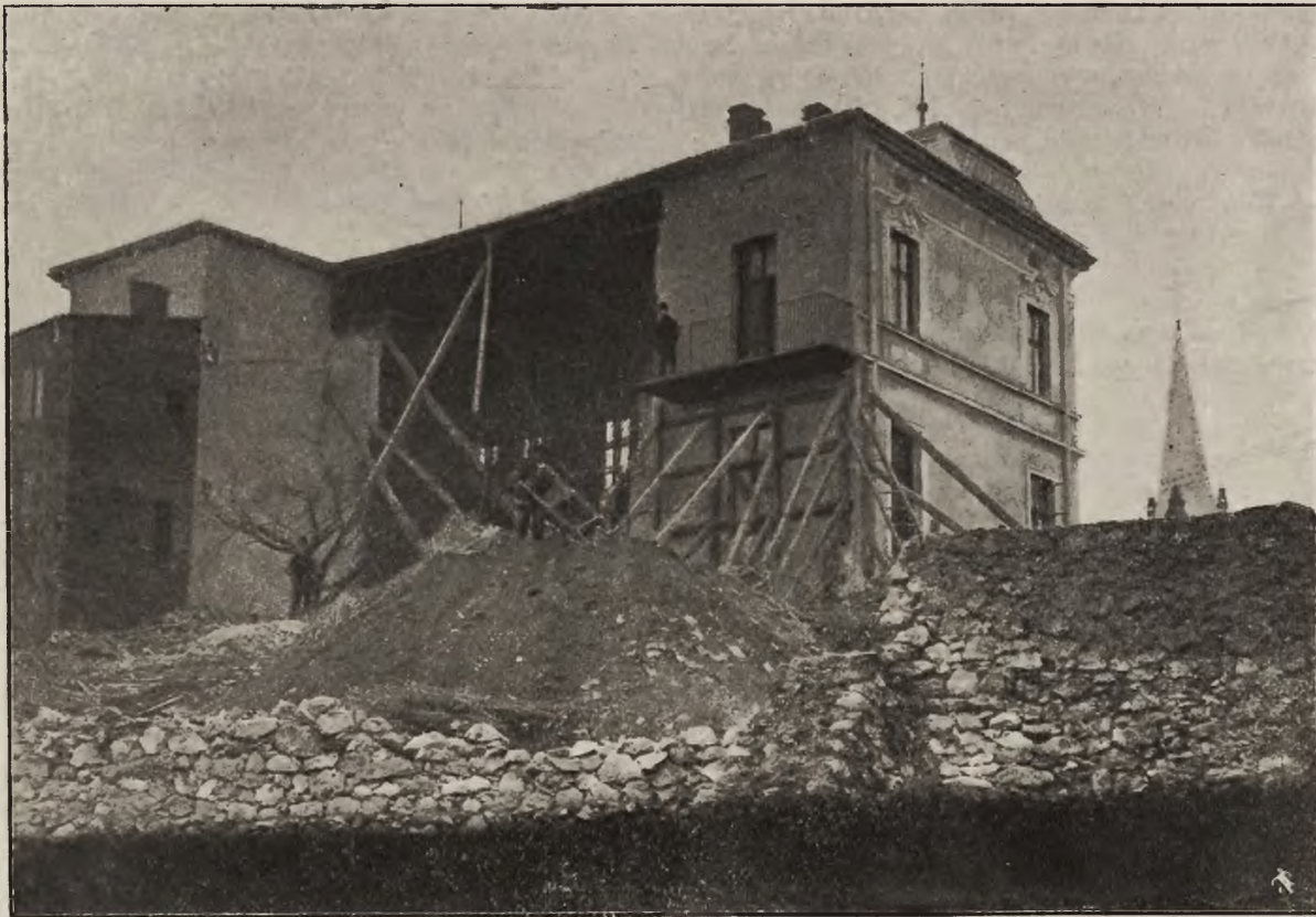
Pod gruzami domu: Widok zawałonego domu w Skałacie, natychmiast po katastrofie.
