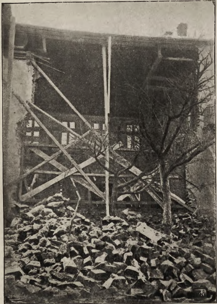
Pod gruzami domu: Widok zawałonego domu w Skałacie na drugi dzień po katastrofie. Mury popodpierane ze wszystkich stron belkami, celem zapobieżenia dalszemu waleniu się.
