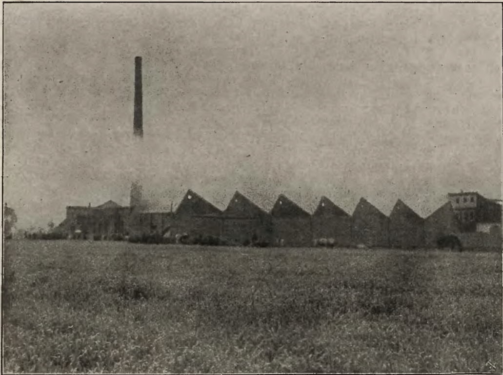
Pożar fabryki szpagatu w Podgórzu: Ogólny widok fabryki po pożarze.
