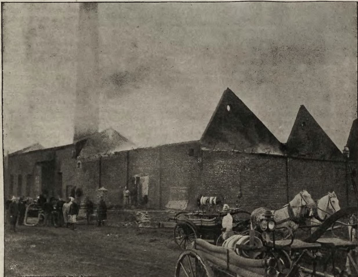
Pożar fabryki szpagatu w Podgórzu: Hala maszyn, zniszczona zupełnie, w godzinę po ugaszeniu ognia.
