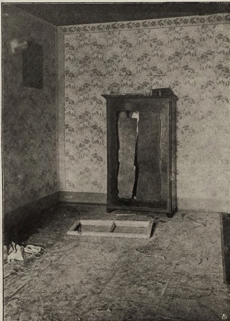
Zamach dynamitowy w Tenczynku: Pokój, który odniósł największe uszkodzenia.
