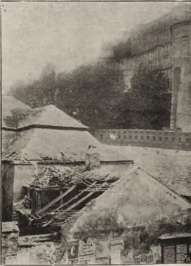
Szanujmy zabytki: Widok przybudówki przy kościółku św. Idziego.
