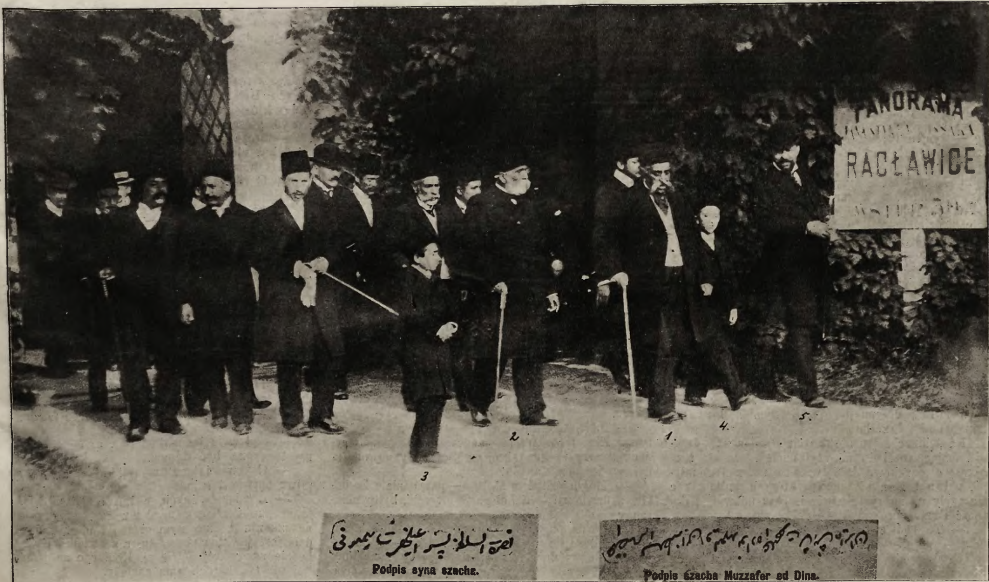
Szach perski we Lwowie: Szach wraz z synem, wnukiem i świtą zwiedza Panoramę racławicką na placu powystawowym: 1. Szach. 2. Wielki wezyr. 3. Syn szacha. 4. Wnuk szacha. 5. Namiestnik hr. Potocki.
