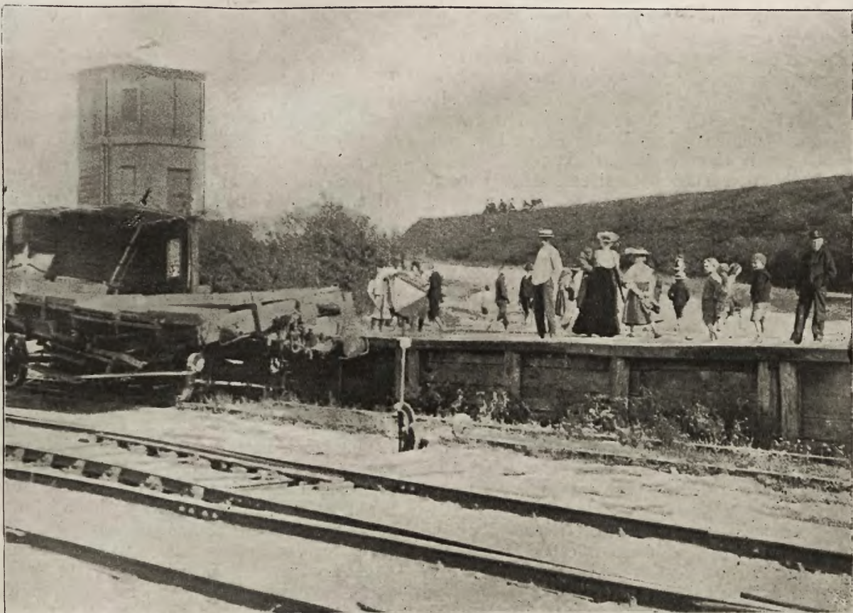
Katastrofa kolejowa we Lwowie: Miejsce katastrofy w godzinę po zderzeniu się pociągów.
