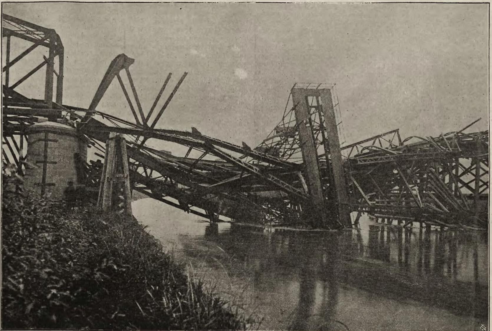
Zawalenie się mostu na rzece Nekar: Widok mostu po katastrofie.
