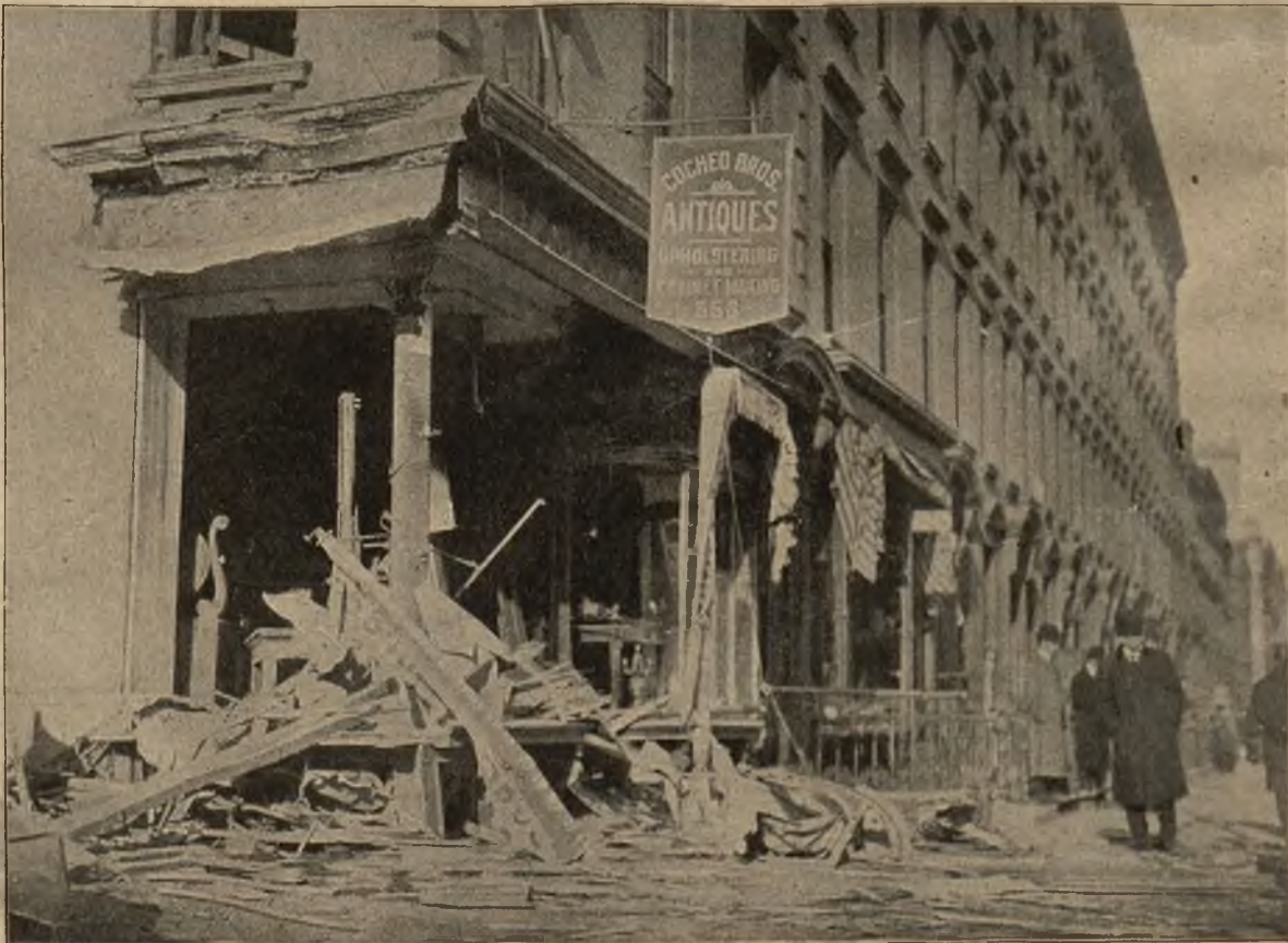
Wielka eksplozja w Nowym Jorku: Ruiny sklepu w pobliżu miejsca katastrofy, zniszczonego siłą wybuchu.
