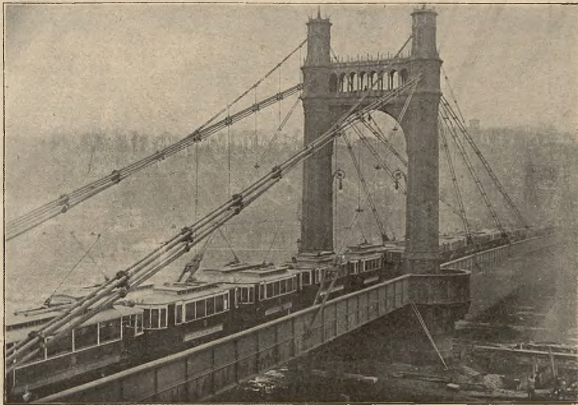
W interesie publicznego bezpieczeństwa: Próba wytrzymałości mostu cesarza Franciszka Józefa w Pradze. Obciążenie próbne 7.280.000 kgr.
