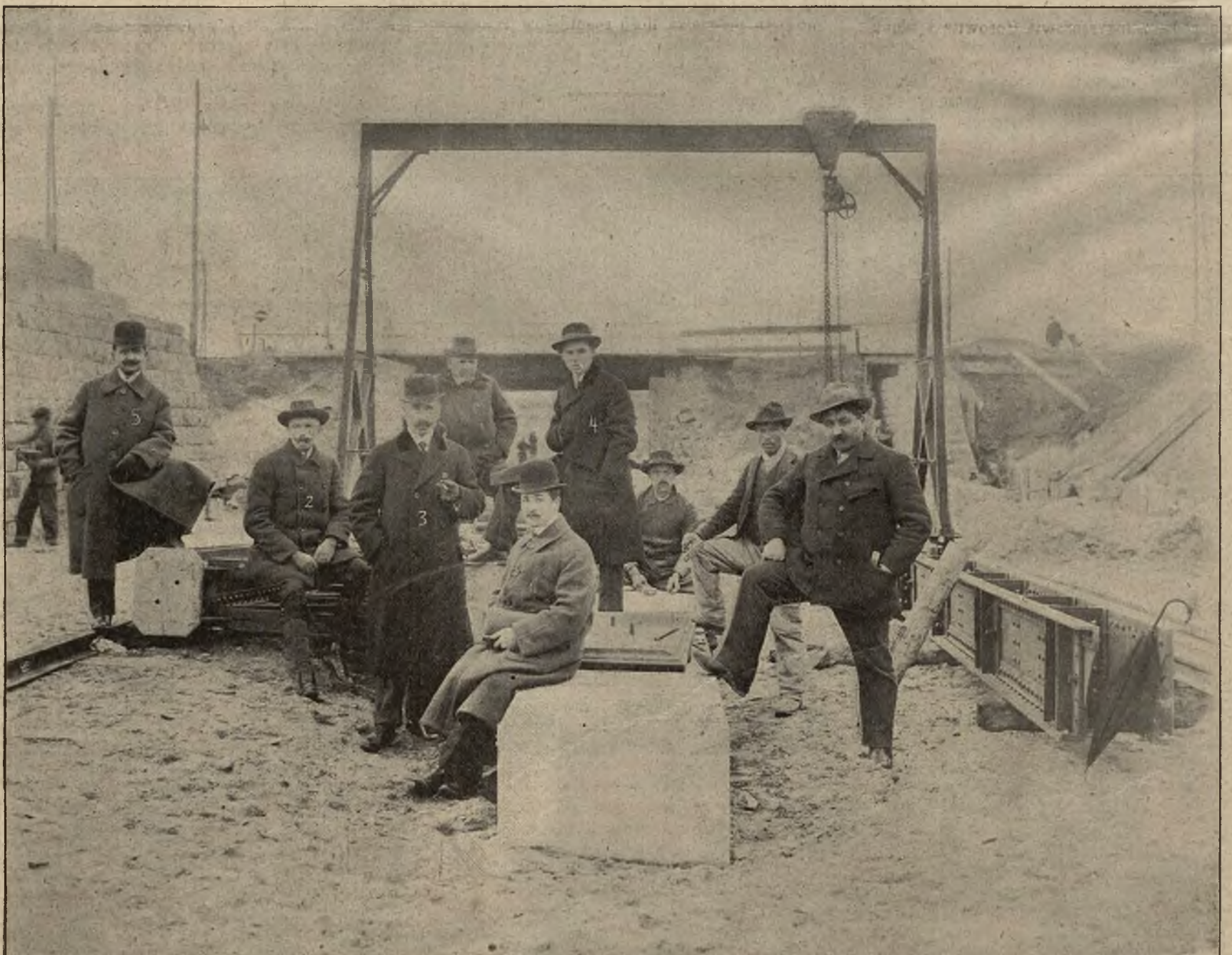
Budowa dworca towarowego w Krakowie: Kierownicy budowy dworca; 1. dr. Juliusz Haraschin, komisarz wykupna gruntów; 2. inż. Kalityński; 3. inż. Horowitz; 4. inż. Munk; 5. urzędnik administracyjny p. Blumenblat.
