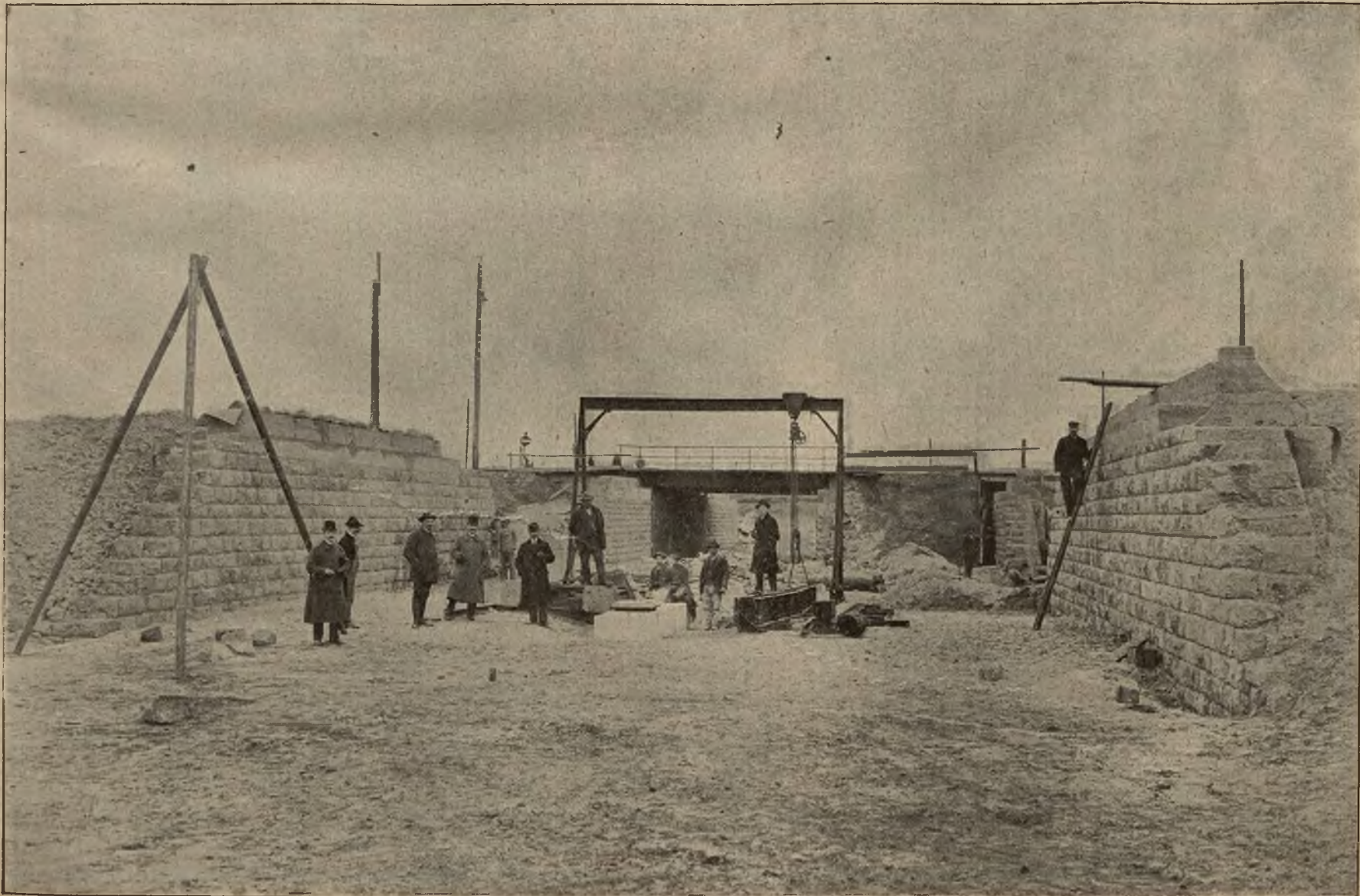
Budowa dworca towarowego w Krakowie: Widok ogólny podkopu na Prądniku Białym.
