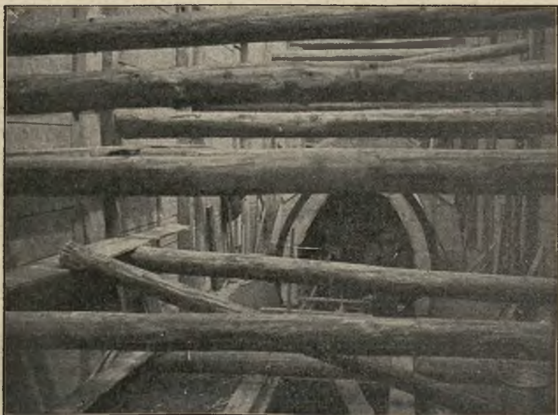
Prace nad Wisłą: Budowa kolektora po stronie krakowskiej.
