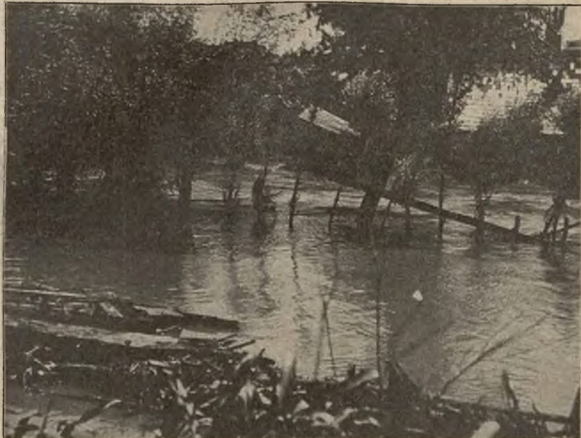
Powódź w Kołomyi: Woda Czarnego Potoku w ul. Bednarskiej, unosząca części mostu i zabudowań.
