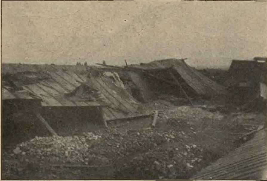
Straszny wypadek: Miejsce katastrofy w cegielni Krajewskiego w Nowym Sączu, gdzie zginęli dwaj gimnazjaliści; (X) miejsce, gdzie stał komin.
