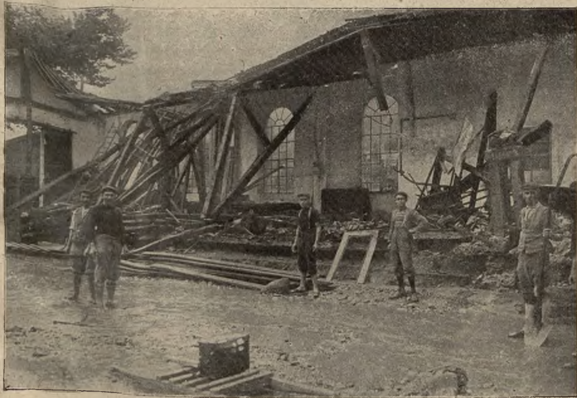
Powódź w Lombardyi: Zniszczone budynki hut w Porlezza.
