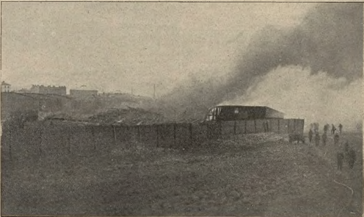
Pożar remiz tramwajowych w Warszawie: Widok płonących budynków.
