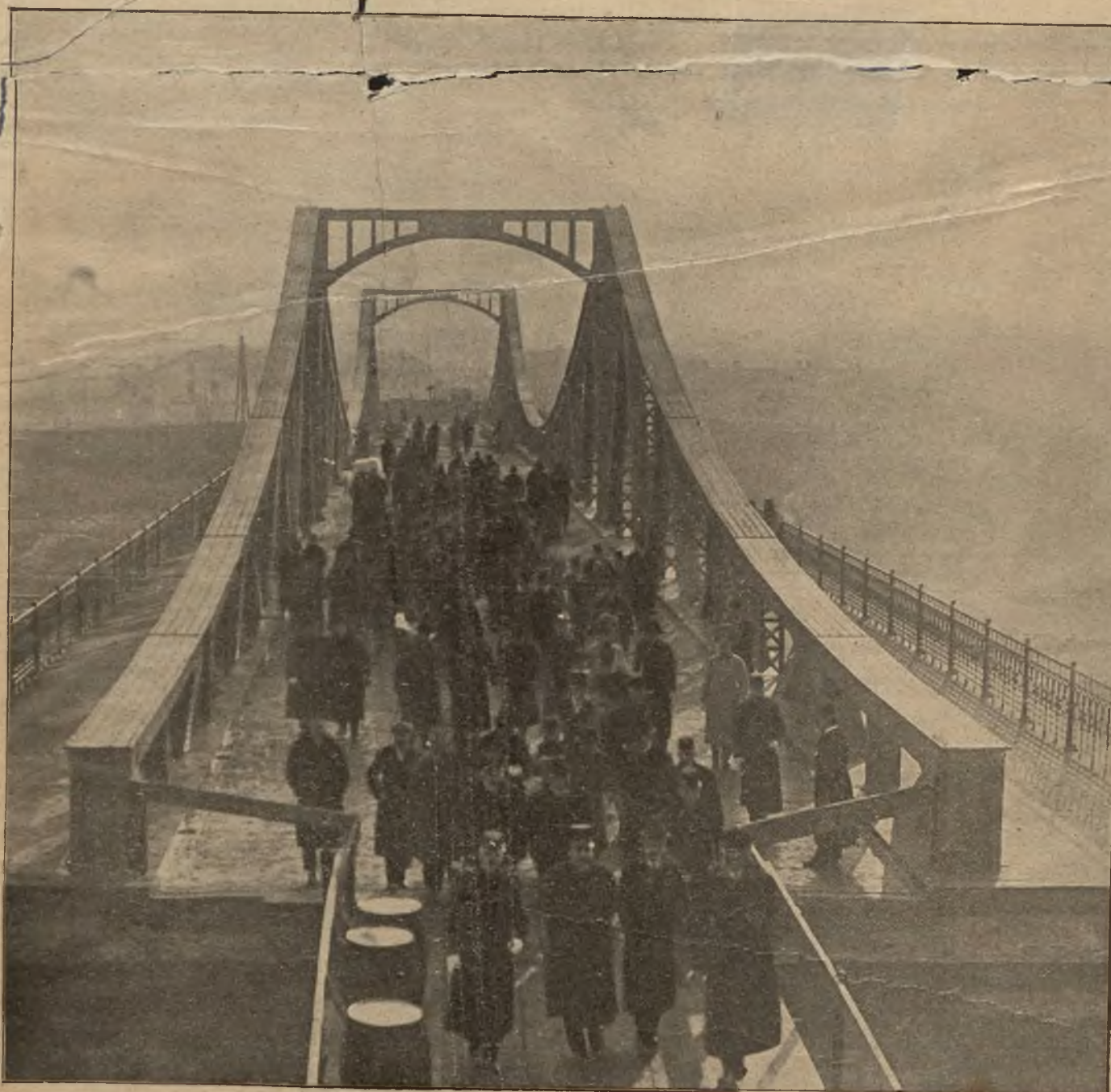
Rozpoczęcie wielkiego dzieła: Uczestnicy uroczystości rozpoczęcia budowy kanałów z ministrami: Długoszem, Zaleskim i Trnką na nowym moście w Krakowie.
