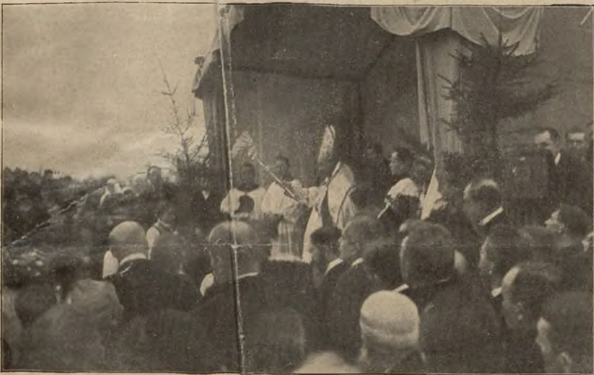
Rozpoczęcie wielkiego dzieła: Uroczystość rozpoczęcia budowy kanałów galicyjskich w Brzeżnicy: ks. biskup Nowak udziela błogosławieństwa.
