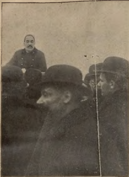
Rozpoczęcie wielkiego dzieła: Minister Zalewski, przemawiający z trybuny podczas uroczystości rozpoczęcia robót kanałowych w Brzeżnicy.
