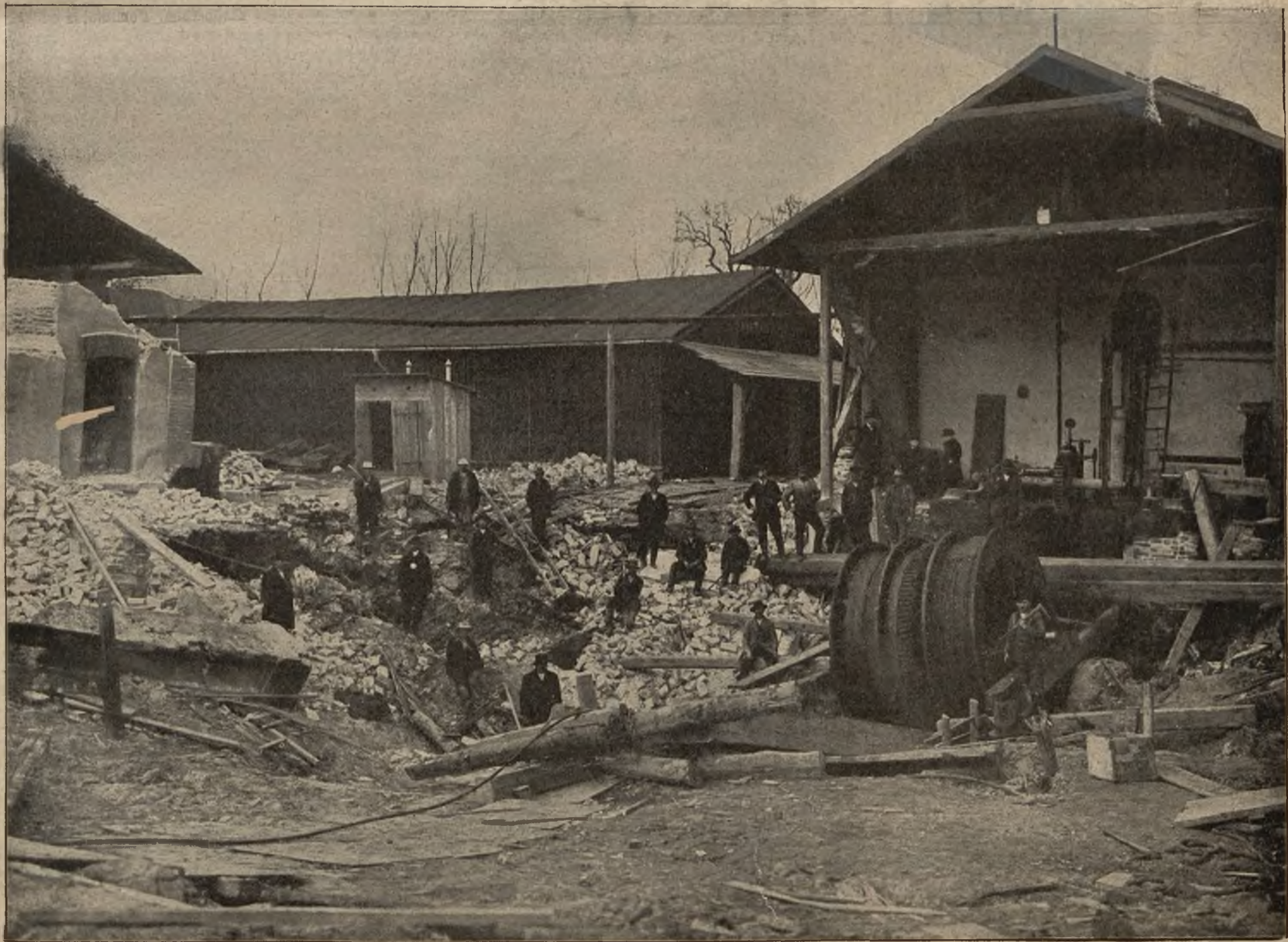
Niepotrzebne alarmy: Zburzone budynki i zapadnięta ziemia około szybu Campi w Bochni.
